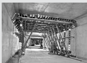
Bednění tunelů
