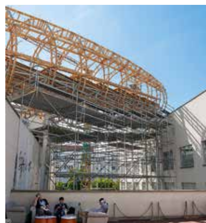
Podepření konstrukce vzducholodi, Galerie DOX, Praha
