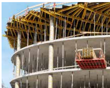
Zásobovací a vyvážecí plošina ze systému TRIO pro transport a dočasné uskladnění materiálu.
