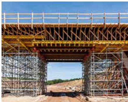
Průjezd pod mostem s překlenovacími nosníky HEB 300.
