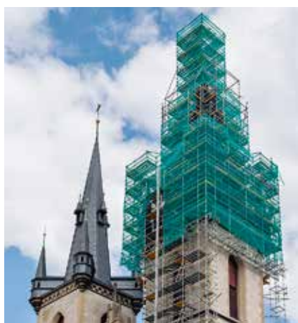
Rekonstrukce střechy věže Kostela sv. Antonína, Praha
