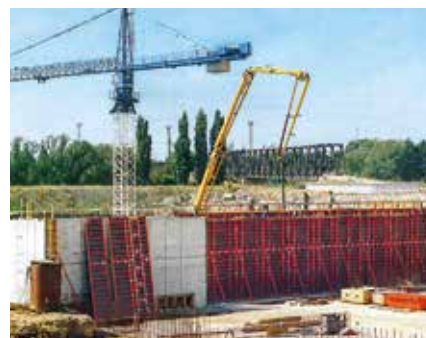
1994 Prodej prvního většího množství bednění TRIO Výstavba čistírky odpadních vod, Plzeň
