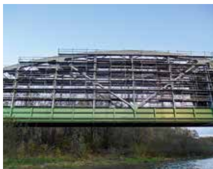
Rekonstrukce obloukového ocelového mostu, Paskov
