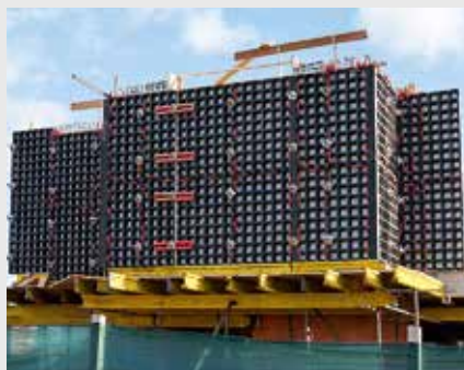
Stavba rodinného domu, Radonice
