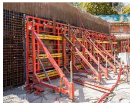
Jednostranné bednění stěn v suterénu panely TRIO s opěrnými rámy SB.
