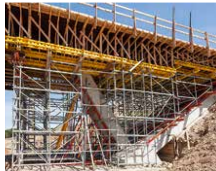
Krajní pole se skruží z lešení PERI UP Flex na závorách SRU.
