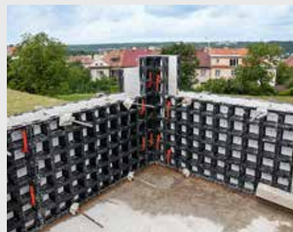
Výstavba vodojemu, Praha
