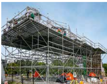
Podepření makety pomníku Stalina pro filmové natáčení, Praha
