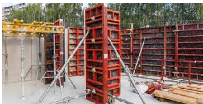
Sloupové bednění TRIO TRS pro čtvercové i obdélníkové průřezy.
