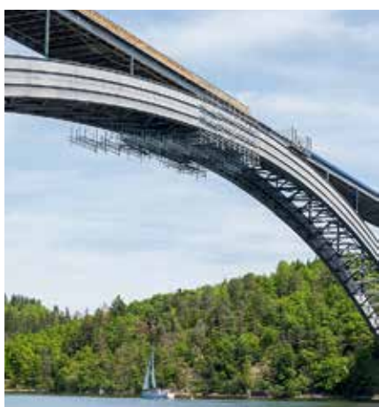
Sanace Žďákovského mostu
