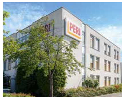
2004 Dostavba 2. patra administrativní budovy v Jesenici
