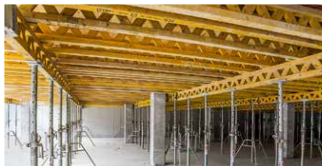
Bednění stropů systémem MULTIFLEX podepřeným stojkami PEP.
