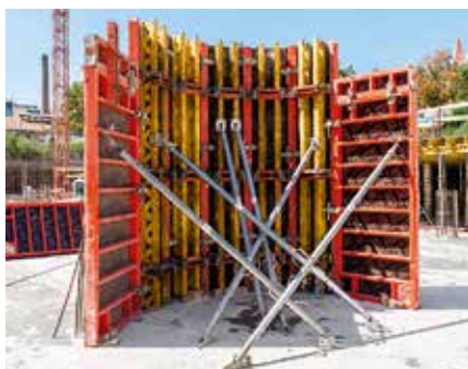
Bednění stěn instalační šachty ze systému kruhového bednění RUNDFLEX a rámového bednění TRIO.
