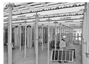
Stropní bednění
