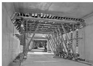
Bednění tunelů
