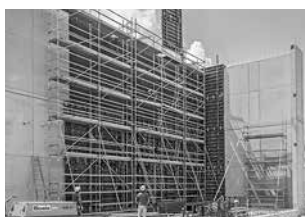
Pracovní lešení na staveništích
