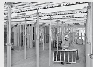
Stropní bednění
