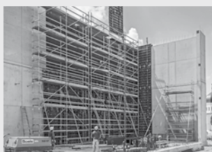
Pracovní lešení na staveništích
