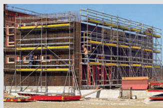
Pracovní lešení na staveništích
