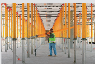
Stropní bednění
