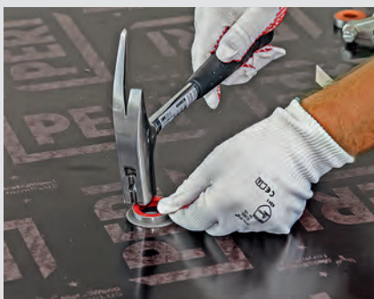
...může být provedena snadno a rychle i přímo na stavbě.
