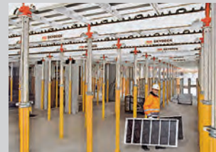
Stropní bednění
