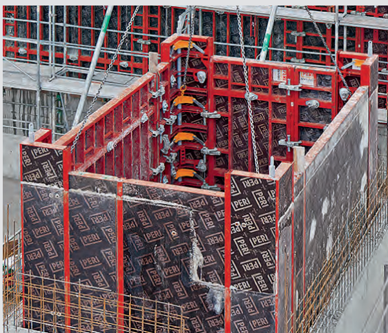
Při uvolnění a nazdvíhnutí jeřábem dochází k odsazení bednění na každé straně o 35 mm.
