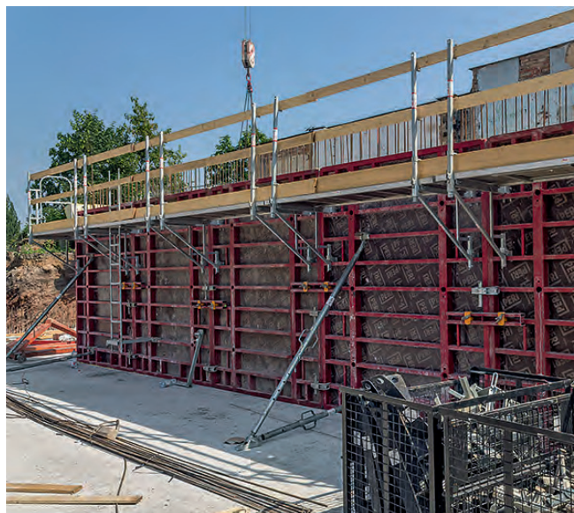
Optimálně zvolené panely MAXIMO s výškou 300 cm byly velkou výhodou pro bednění stejně vysokých stěn.
