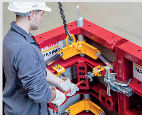
Páčidlem se nazdvihne odbedňovací mechanismus, aby se bednění uvolnilo od betonu. Nakonec následuje zavěšení na jeřáb.
