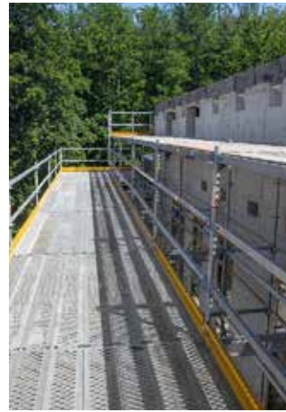
Lešení pro montáž botek na uložení střešních vazníků atria.
