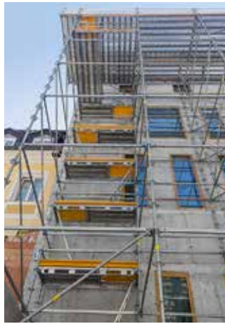
Součástí konstrukce bylo i výstupové pole ze systému PERI UP Flex s žebříky.
