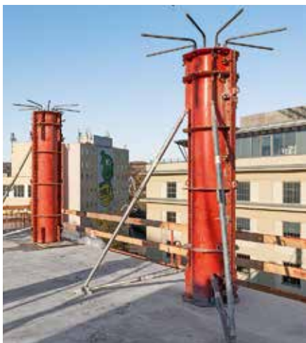
Bednění kruhových sloupů SRS umožňuje vytvoření perfektního povrchu betonu.
