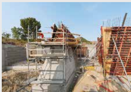
Bednění věží V2 a V3 s různými sklony.
