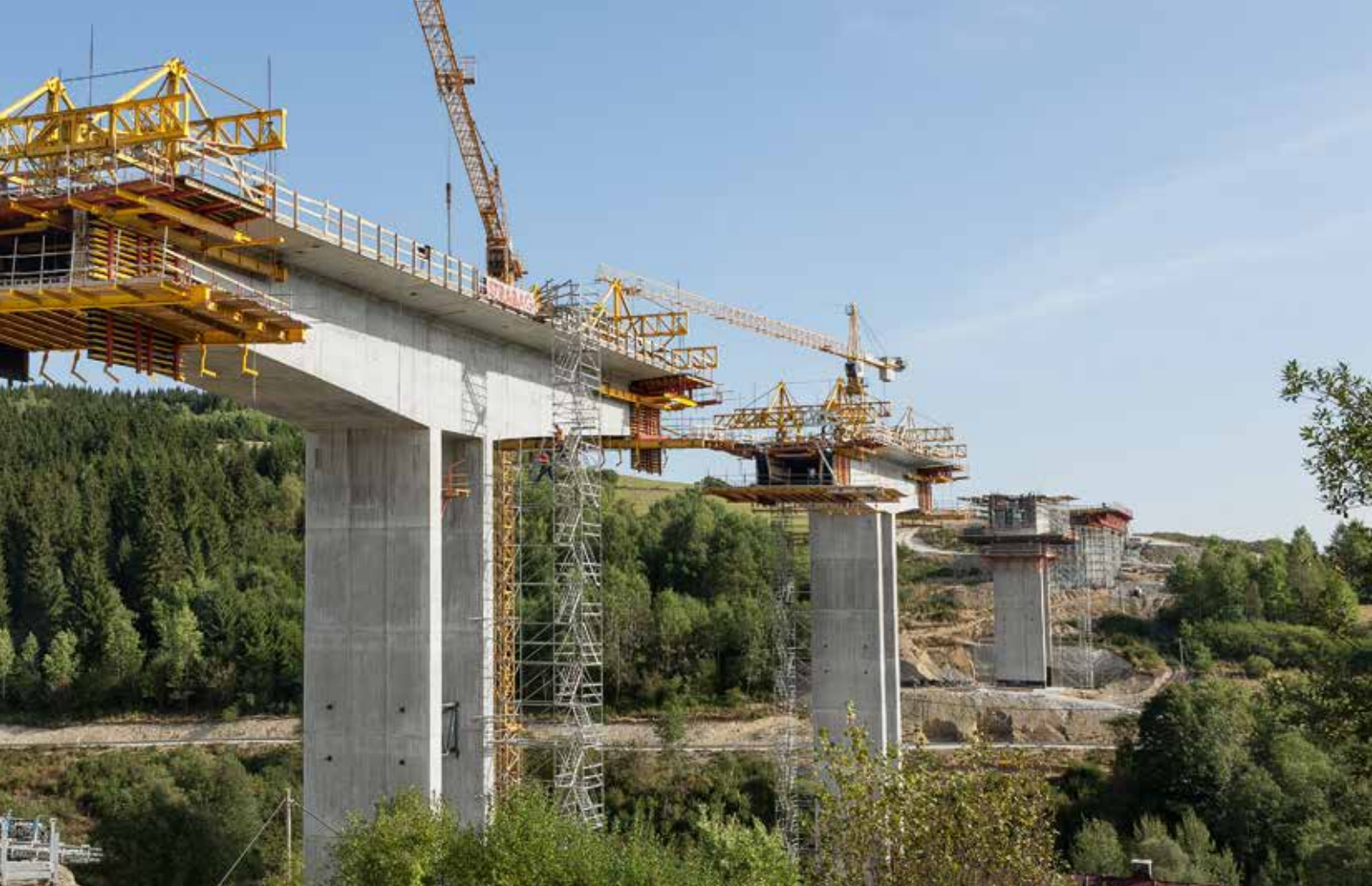
Schéma letmé betonáže.
