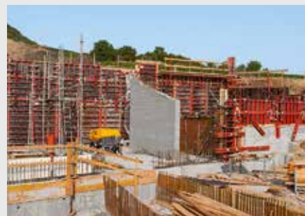
Bednění stěn muzea systémem TRIO s finálním otiskem prken na betonové stěně.
