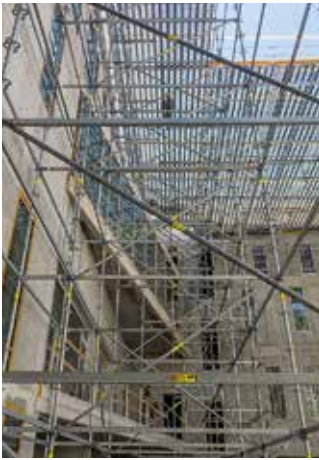
Prostorová konstrukce s horní podlahou a hliníkovými příhradovými nosníky.
