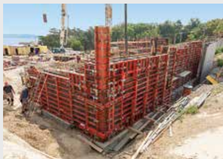
Bednění stěn muzea systémem TRIO s finálním otiskem prken na betonové stěně.
