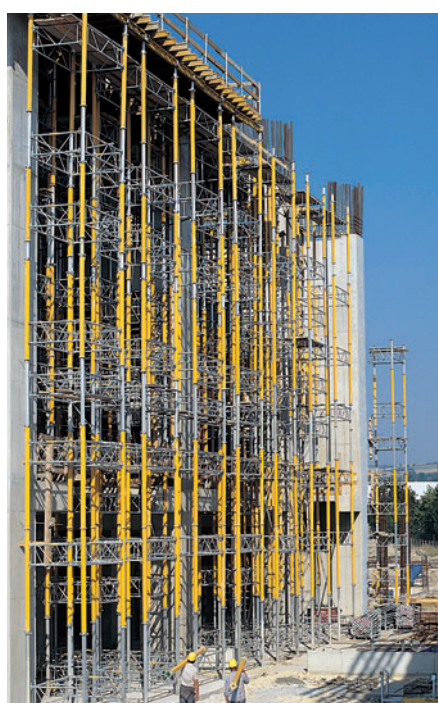
Pro bednění vyložené stropní desky byly použity podpěrné věže MULTIPROP, vysoké 20 m.
