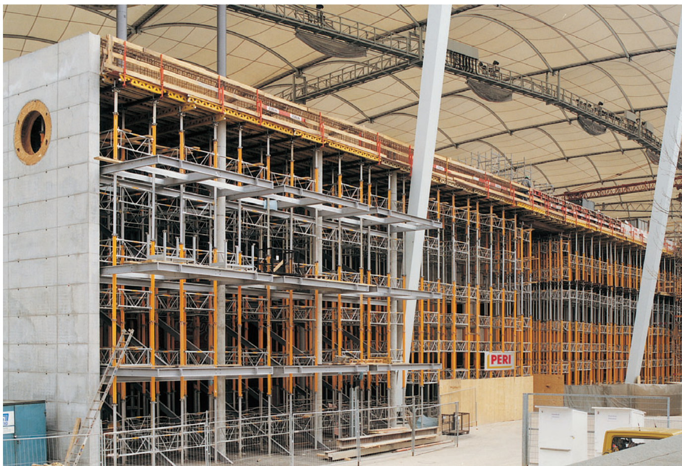
Podpěrné lešení MULTIPROP vysoké 14,00 m na ploše 3.500 m 2 .
