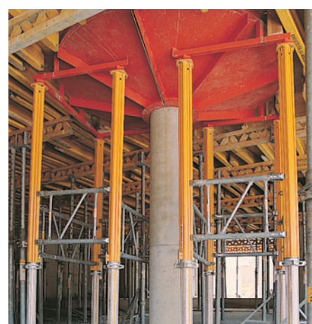
Podepření bednění hlavice sloupu stojkami MULTIPROP 350 s rámy.
