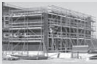
Pracovní lešení na staveništích
