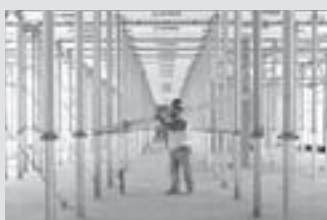
Stropní bednění
