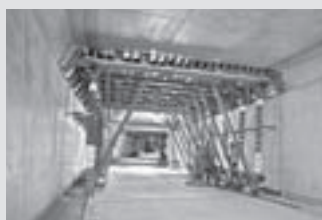
Bednění tunelů
