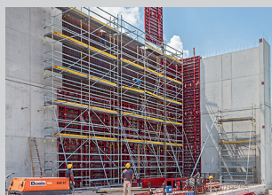
Pracovní lešení na staveništích
