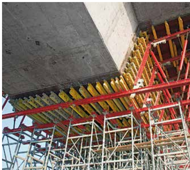
Sestavy bednění se dají přichytit ke konstrukci vrchní stavby mostu. Pro příští záběr je podpěrná konstrukce volná a může být demontována.
