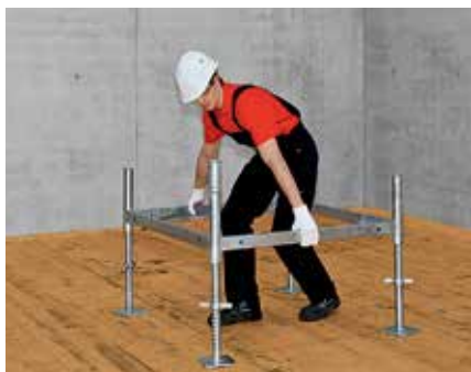
Postavení základního rámu – nastavení patek na požadovanou výšku a vyrovnaní.
