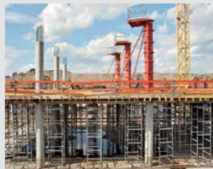
Podpěrná věž je únosná také bez nasazení diagonál (dodržovat typovou zkoušku).
