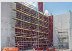
Pracovní lešení na staveništích
