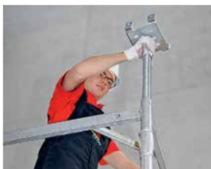
Nastavení stavěcích hlav na požadovanou výšku a nasazení.
