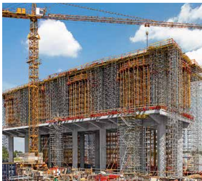
Ideální kombinace podpěrných věží ST 100 a modulového systému MULTIPROP. Pronajímatelné ocelové závory SRZ a SRU z programu stěnového bednění VARIO sloužily k rozdělení zatížení.
