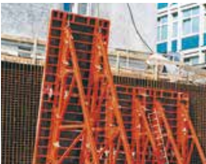
Pevné spojení umožňuje přemísťování celých kompletů sestav.
