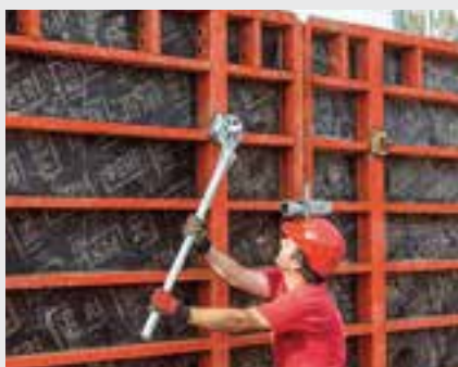
Klíč pro spínání slouží k snadnému utahování a uvolňování křídlových matic bez použití kladiva, velká úspora času především u horních spínacích míst.
