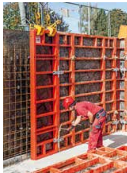
Víceúčelové panely s šířkou 72 cm se nasazují jak u vnějších rohů, tak také u rovných stěn.
