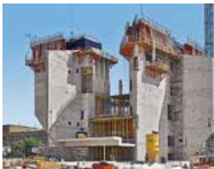
CaixaForum Saragossa, Španělsko
