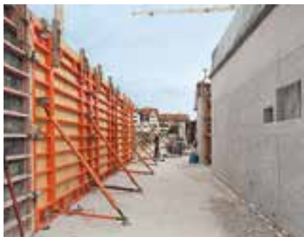
TRIO Struktur je varianta osvědčeného rámového bednění, která je použitelná s celým příslušenstvím TRIO.
