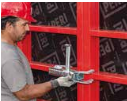
Zámek BFD lze obsluhovat jednou rukou.
