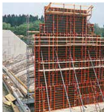
S panely TRIO 330 je možné rychle zhotovit velmi vysoké stěny – pouhé 4 panely vytvoří stěnu vysokou 13,20 m.
