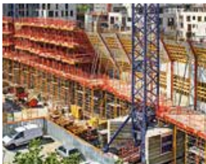
Administrativní budova Boulogne-Billancourt, Francie
