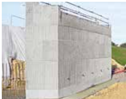
Bednění TRIO Struktur může být opatřeno různými deskami a překližkami, což ponechává velkou volnost ve vybavení panelů.
