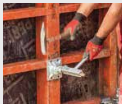
T-klíč usnadňuje obsluhu sepnutí.
