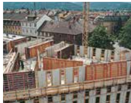
TRIO Struktur může být kombinováno se standardními panely TRIO. To je velkou výhodou, protože bývají zvláštní povrchy často vyžadovány pouze na jedné straně.
