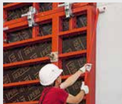
Uvolnění panelů probíhá s pomocným páčidlem snadno a bez poškození. Vodicí kladka brání poškození betonové stěny.
