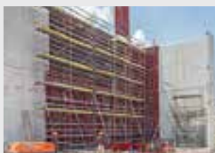
Pracovní lešení na stavebních
