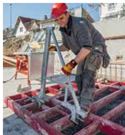
Pracovní lávky odpovídající šířky se namontují na panel a zůstávají na bedněni i během dočasného uskladnění.
