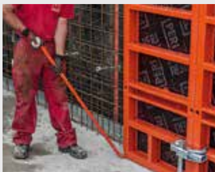
Zkosený roh TRIO usnadňuje vyrovnání prvků bez nutnosti použít kladivo. Obzvláště snadno to jde při použití pomocného páčidla.
