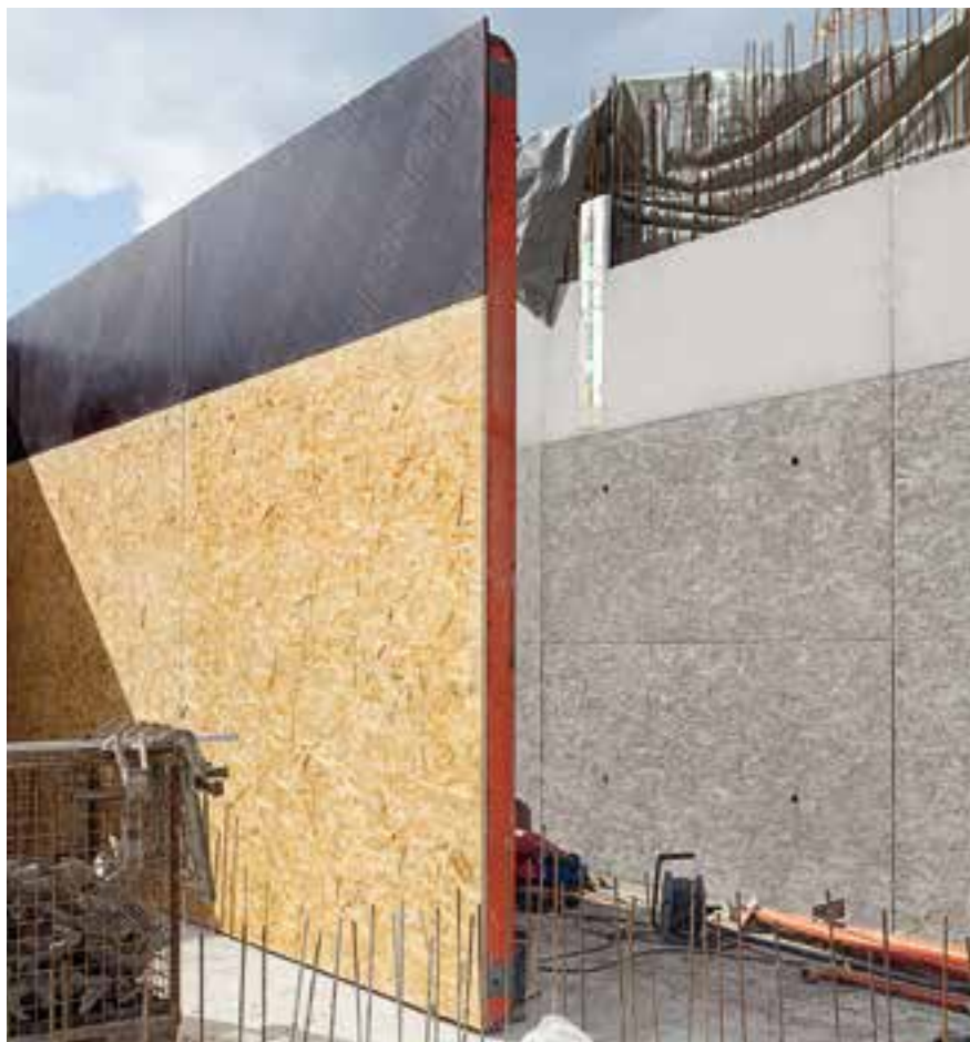
S TRIO Struktur jsou splněny požadavky na kvalitu pohledového betonu SB 3. Desky OSB a překližky FinPly se našroubují čistě ze zadní strany.
