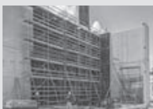
Pracovní lešení na staveništích
