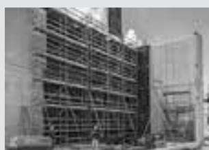
Pracovní lešení na staveništích
