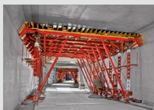
Bednění tunelů
