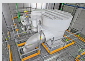
Pracovní lešení na staveništích
