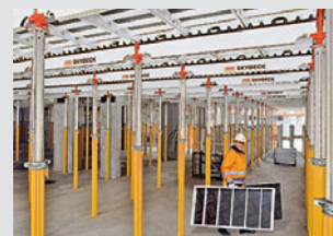
Stropní bednění
