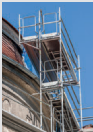
Využití konzol UCB v systému PERI UP T 72 pro přístup na střechu.
