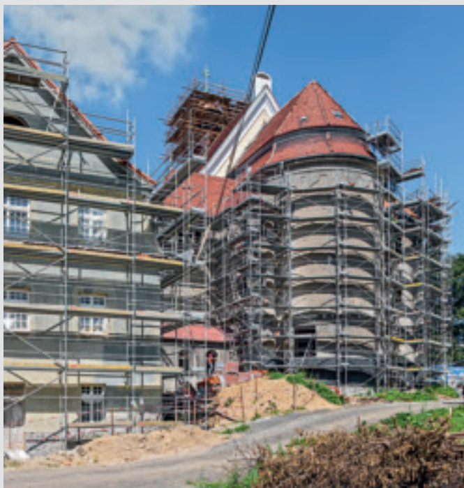
Využití konzol UCB v systému PERI UP T 72 pro přístup na střechu.
