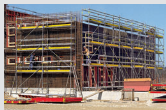
Pracovní lešení na staveništích
