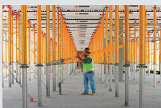
Stropní bednění
