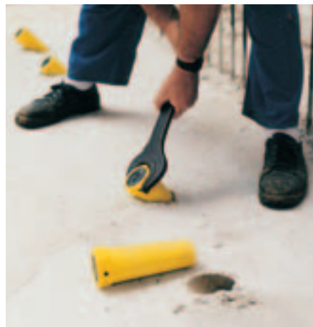
...a snadná demontáž montážních kónusů po betonáži.
