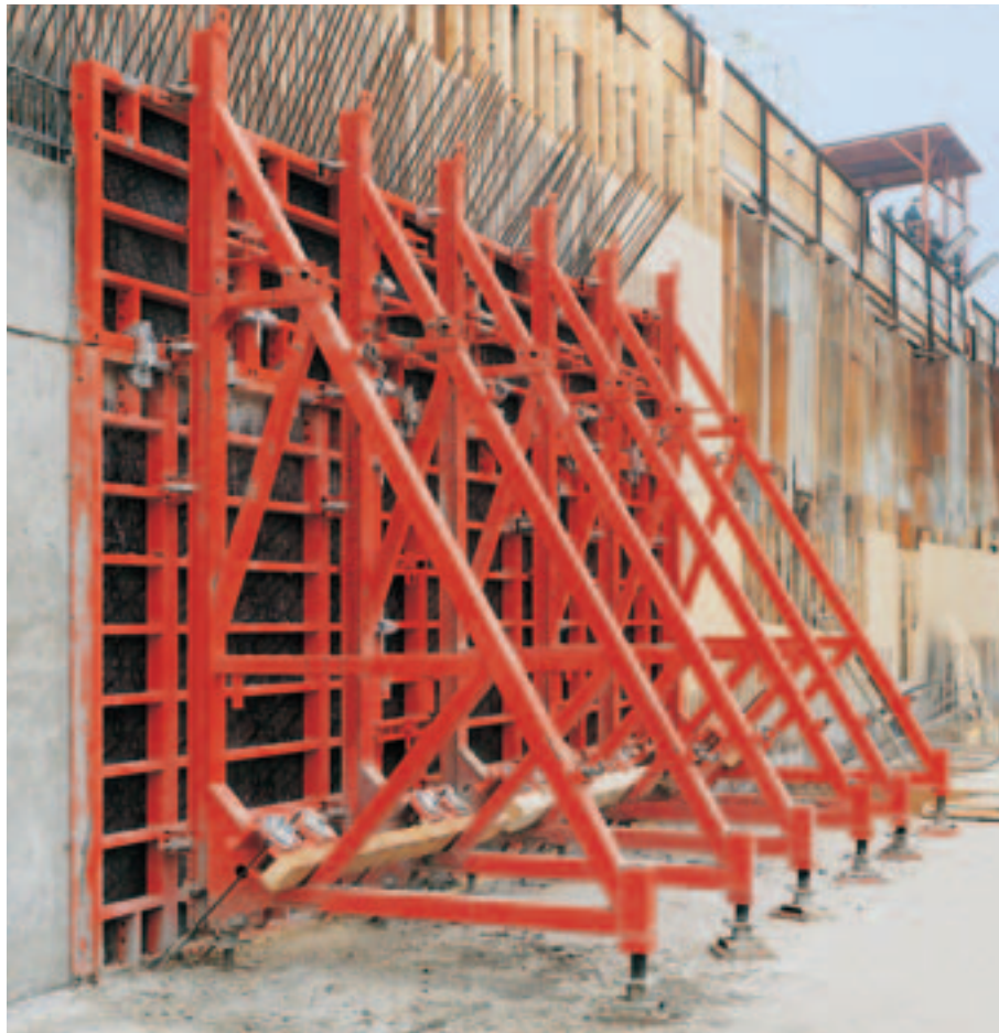
Opěrné rámy SB-B a SB-C s rámovým bedněním PERI TRIO, výška betonáže 3,50 m.
