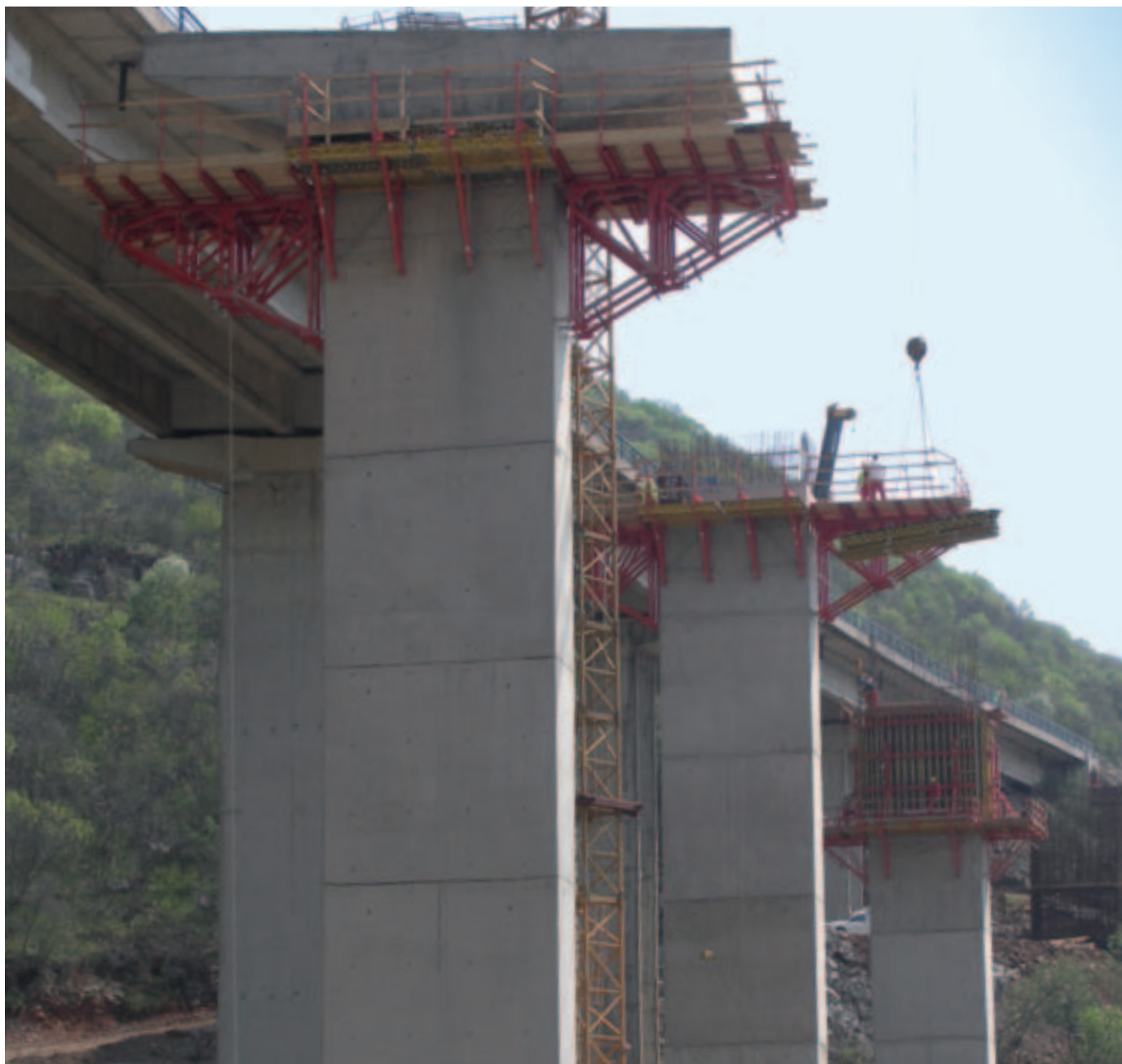
Použití systému opěrných rámců SB-A, B jako vysoce únosné konzoly pro pracovní a podpěrné lešení.
