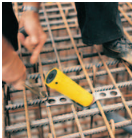
Jednoduché uchycení kotvy k výztuži...
