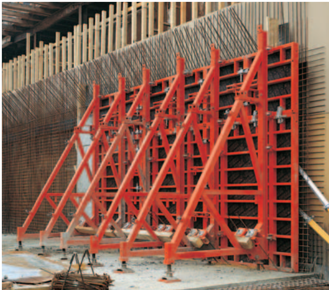
Opěrné rámy SB-B, C se systémem TRIO, pro betonáž do výšky 3,90 m.
