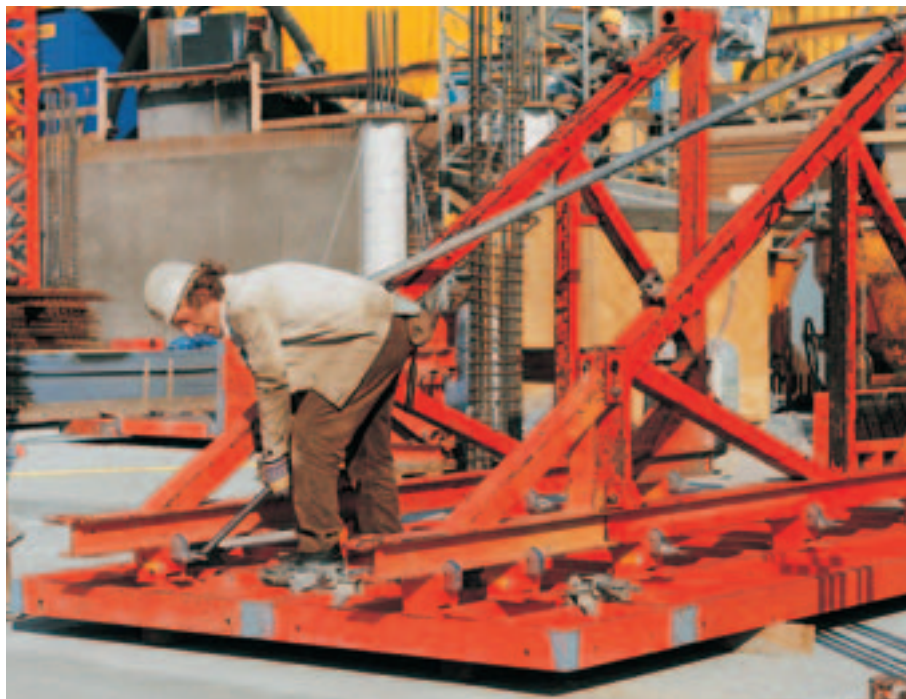
Montáž opěrného rámu SB-A, B, C na ležícím panelu TRIO.
