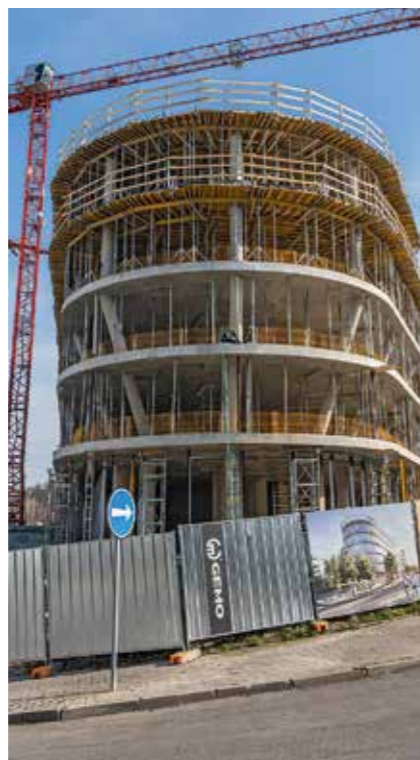
24 Podpora a spolupráce zaručují úspěch projektu Administrativní budova Roztyly Plaza, Praha
