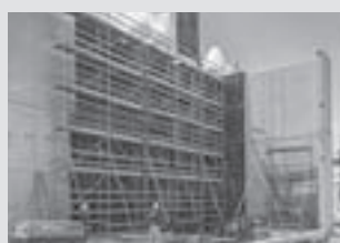
Pracovní lešení na staveništích
