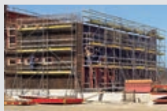
Pracovní lešení na staveništích
