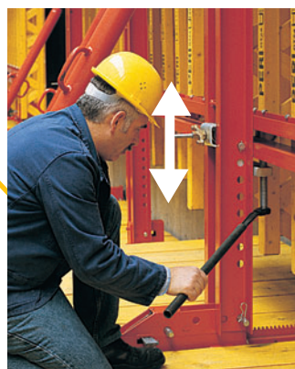
Pomocí vertikální aretace lze jemně doladit výšku bedně ...u VARIO GT 24 ...u PERI TRIO
