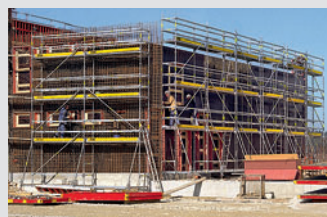
Pracovní lešení na staveništích
