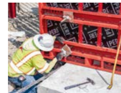
Inovativní spojovací technika prostřednictvím X šroubů a T kotev umožňuje rychlou montáž a demontáž bednění.
