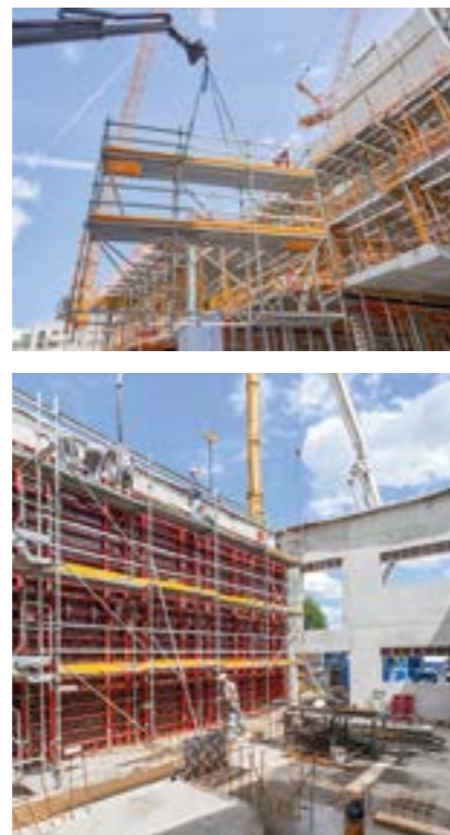
Před bedněním a stěnami může být armovací lešení PERI UP nasazeno bez kotvení a zátěží.
