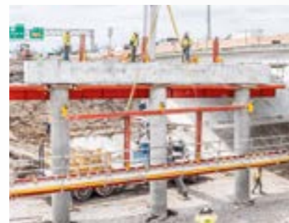
Inovativní metoda odbednění Split-Soffit urychluje pracovní takty a snižuje počet potřebných sad bednění.
