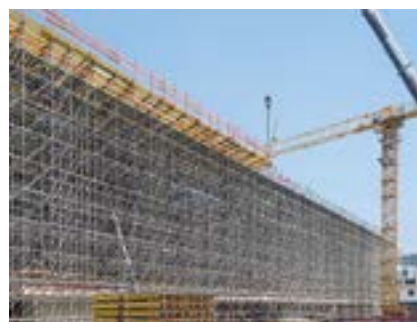
Podpěrné věže PERI UP jsou optimálně sladěné se systémy stropního bednění PERI a tím i s běžnými rozměry ocelových a dřevěných výrobků.
