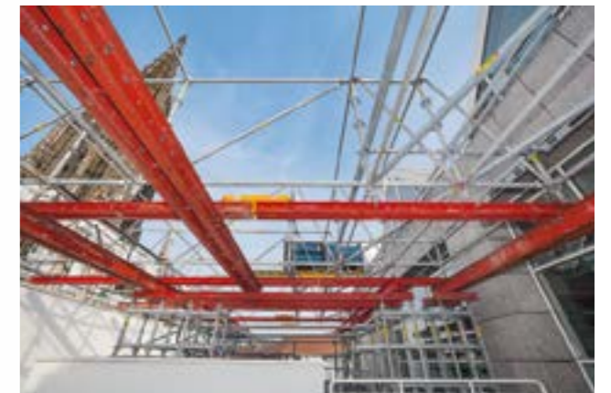
Ve stísněných prostorech nebo u nestabilního podloží může být systém VARIOKIT využit jako nosná konstrukce pro různá řešení lešení.
