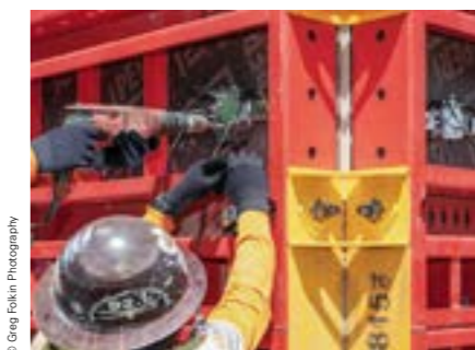
Senzor tlaku čerstvého betonu je dalším prvkem pro urychlení procesu betonáže.
