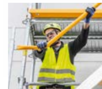
Samovolné zajištění dílů a montáž téměř bez použití nářadí s umístěním na předem montované zábradlí.
