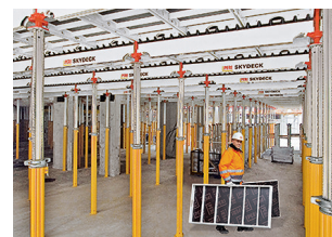
Stropní bednění
