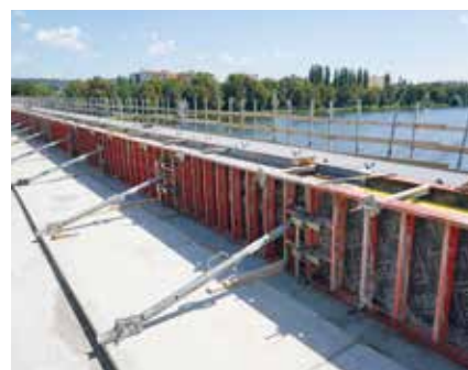
Systém rámového bednění DOMINO pro zhotovení betonových zídek kolejového lože.
