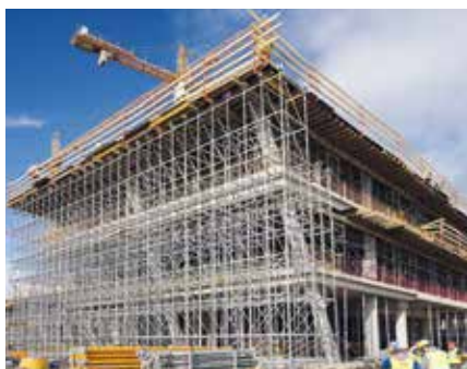
Podpěrná konstrukce ze systému lešení PERI UP Flex na šikmé části budovy.
