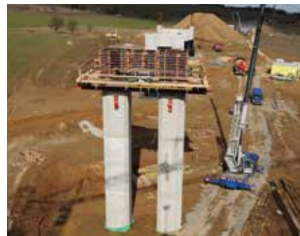
Bednění příčnicku na standardních pilířích pomocí konzol MATFLEX.
