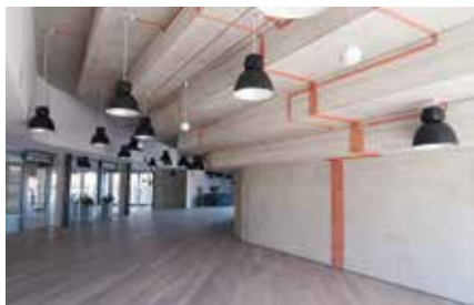
Strop vestibulu a chodby pod posluchárnou s viditelnými plochami pohledového betonu.
