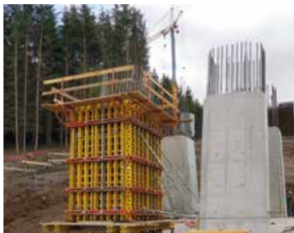
Základní bednicí forma ze systému VARIO GT 24 předem vyrobená v dílně PERI.
