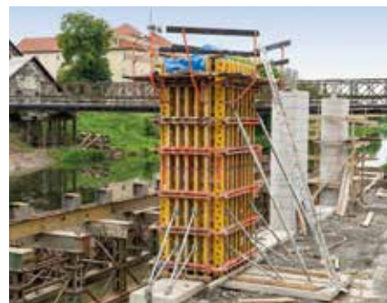
Bednění pilíře pomocí nosníkového bednění VARIO GT 24.
