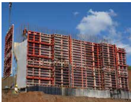
Rámové bednění TRIO nasazené na opěře do výšky 6 m.
