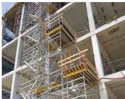
Zásobovací a vyvážecí plošiny na podpěrných věžích z lešení PERI UP.
