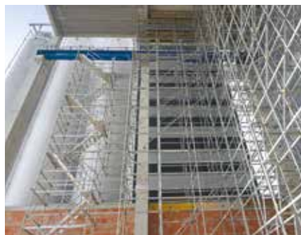
Podepření průvlaků ve výšce 28,7 m systémem lešení PERI UP.
