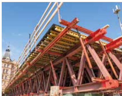
Ztužení příhradových nosníků KMT a vykonzolování pochozího okraje mostovky.
