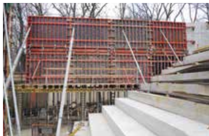
Betonáž obvodových stěn auly se systémovým bedněním TRIO až do výšky 5,40 m.
