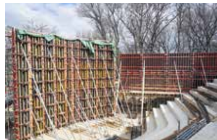
Kruhové bednění RUNDFLEX nasazené pro betonáž obloukové promítací stěny.
