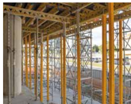
Kombinace podpěření stojkami MULTIPROP a podpěrnými věžemi ST 100.
