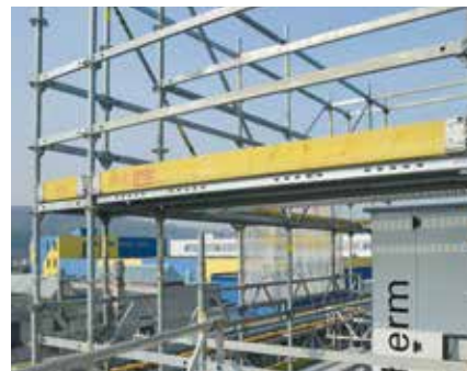
Konstrukce z lešení pro izolaci vzduchotechnické jednotky s volně průchozími rohy.
