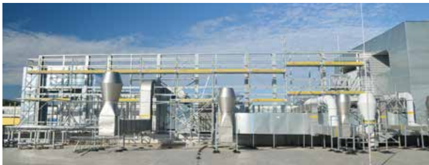
Pracovní lešení PERI UP Flex v kombinaci s PERI UP Easy pro montáž protihlukové stěny.
