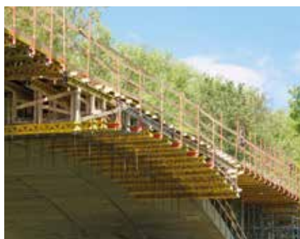
Podvěšené dvojice nosníků GT 24 kotvené táhly skrz stávající mostovku.
