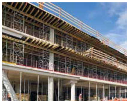
Podpěření stropního bednění MULTIFLEX u větších světlostých výšek věžemi ST 100.
