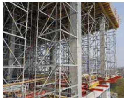
Založení podpěrných věží s výškou 7,5 m na nosníku ST-A4.
