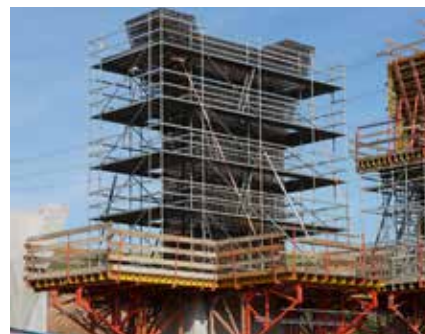
Armovací lešení PERI UP k provedení výztuže na hlavici pilíře.
