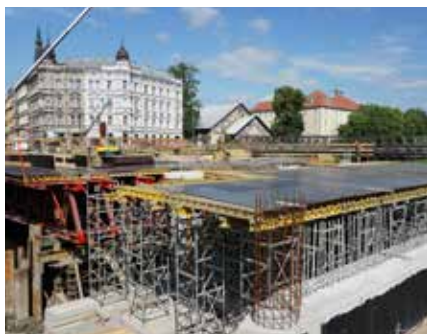
Podepření krajního pole mostu na lehké skruži z podpěrných věží ST 100.
