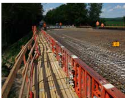
Začlenění systémem rámového bednění DOMINO pro betonáž rozšířené mostovky.
