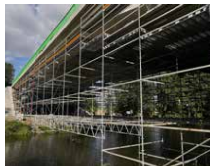
Zavěšené lešení PERI UP pro sanaci spodní části mostu.
