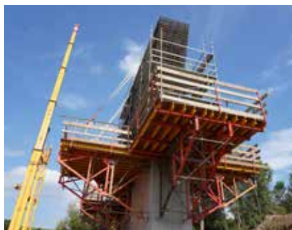
Plošiny ze systému VARIO GT 24 na opěrných rámech SB.
