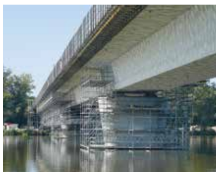
Zavěšené lešení PERI UP Flex pro sanaci pilíře a výměnu ložisek.
