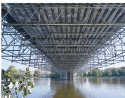
Pohled na spodní podlahu na příhradových nosnících ULA 825.
