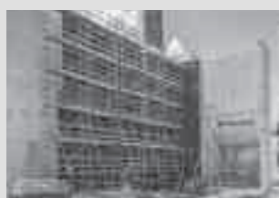
Pracovní lešení na staveništích
