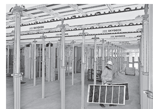
Stropní bednění
