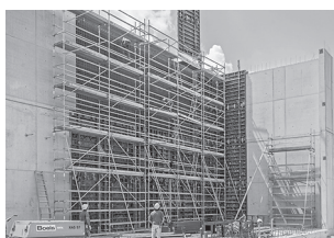
Pracovní lešení na staveništích
