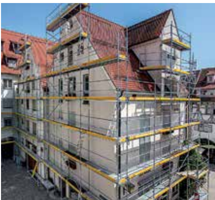
Sanace bytového domu, Ulm, Německo
