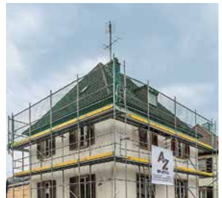
Oprava domu, Landau, Německo
