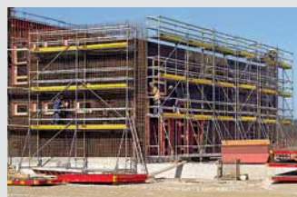
Pracovní lešení na staveništích
