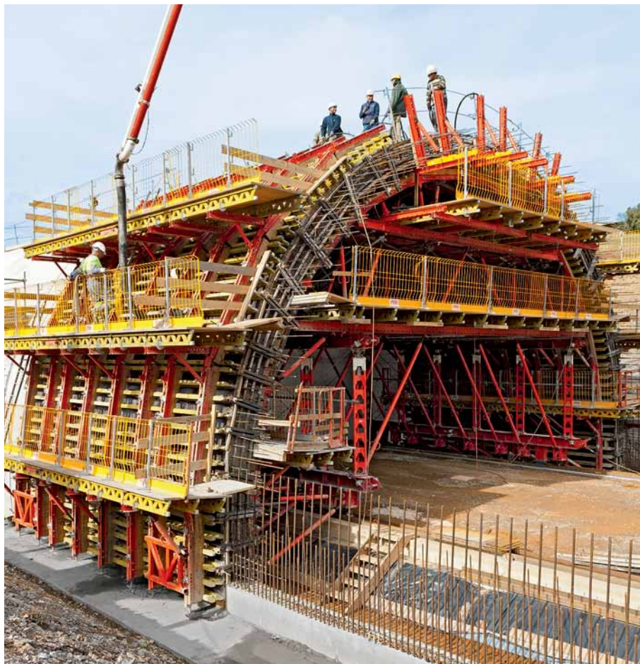
PROKIT EP 110 vytváří ochranu všech volných okrajů pracovních plošin tohoto tunelového bednění.
