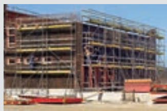
Pracovní lešení na staveništích
