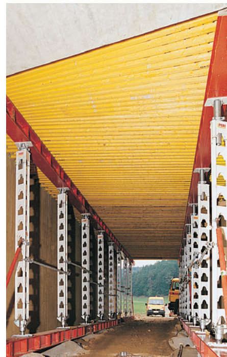
60 bm mostovky podopřeny systémem HD 200.
