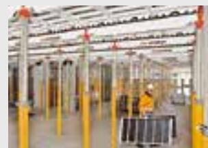
Stropní bednění
