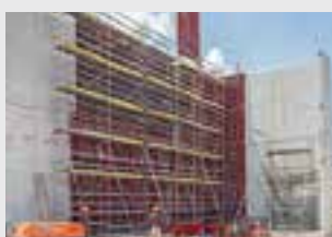
Pracovní lešení na staveništích
