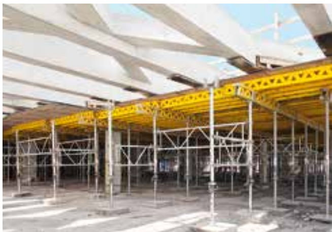
Ke zhotovení průvlaků z monolitického betonu sloužil systém MULTIFLEX, stojky PEP byly vzájemně propojeny rámy PRK do podpěrných věží.
