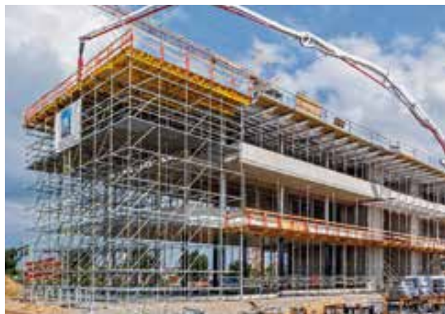
Kompletní řešení od jednoho dodavatele: stěnové a stropní bednění i podpěrné a armovací lešení byly optimálně sladěné přesně podle požadavků projektu..
