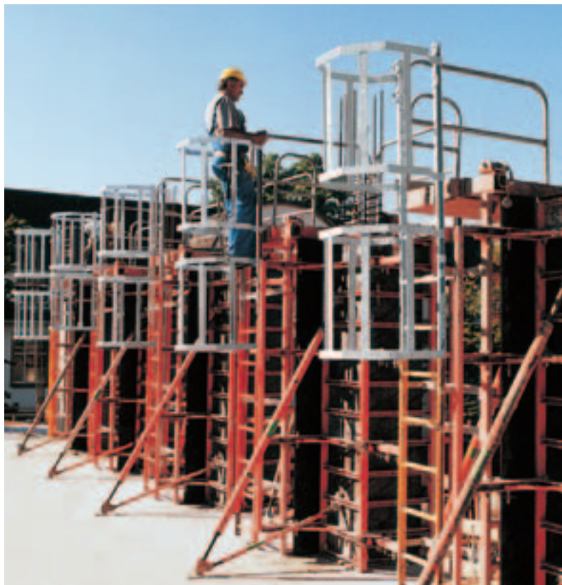
Žebříkové výstupy pro bezpečný přístup na betonářskou lávku.
