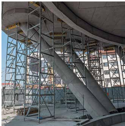
Dočasné podepření stropní desky podpěrnými věžemi ST 100.
