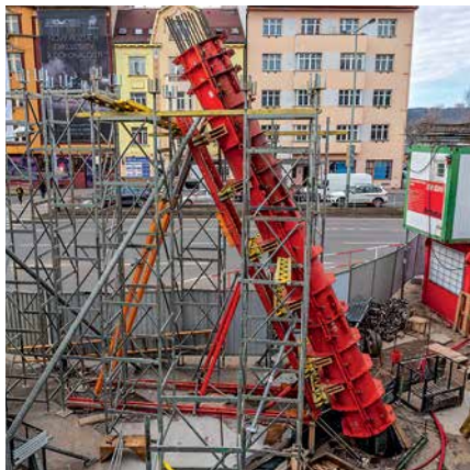
Ocelové bednění sloupů SRS nasazené pro nakloněné sloupy.
