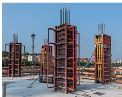
Sloupcové bednění QUATTRO a TRIO použité na obdélníkových sloupech.
