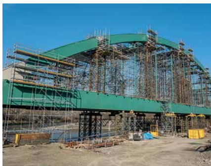
Pohled na lešení k obloukům. Celkem bylo nasazeno 120 t lešení.
