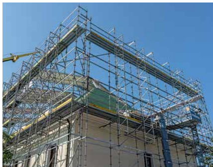
Osazování zastřešení na nosnou konstrukci z lešení PERI UP Flex.
