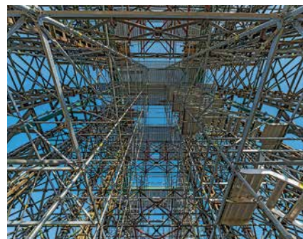
Pohled na plošinu v nejvyšším místě oblouku, doplněnou o výstupovou věž.
