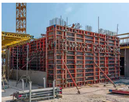
Osvědčený systém TRIO nasazený pro bednění všech stěn budovy.
