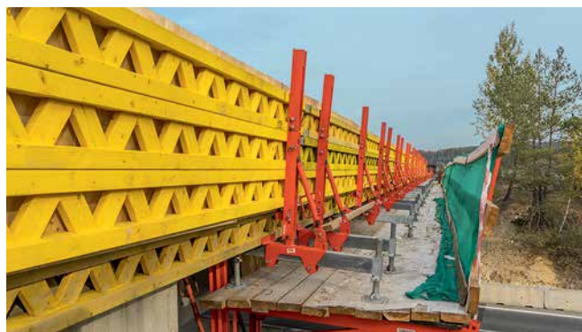
Doplnění bednění římsy na pracovní lávce VGK.
