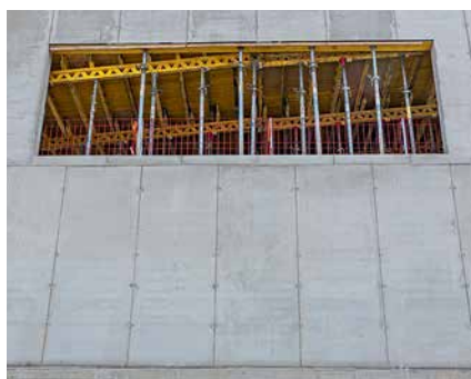
Kvalitní povrch pohledové stěny se systémem TRIO 330.
