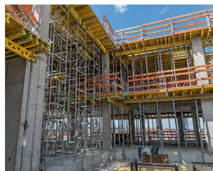
Podepření stropní konstrukce podpěrnými věžemi ST 100.
