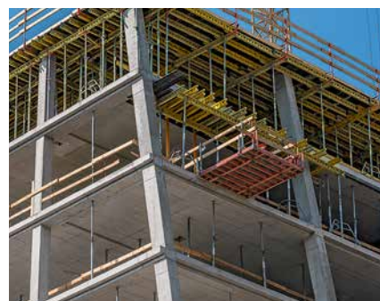
Zásobovací a vyvážecí plošina ze systému TRIO a RCS.
