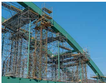
Vyvěšené lešení vně půdorysu mostu a přechod mezi etapami pomocí ULA 8,00 m.
