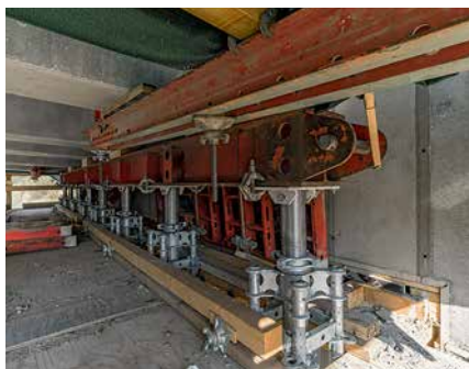
Podepření prefabrikovaných nosníků u opěry.
