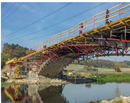
Konzoly SRU vytvořené ze závor SRU a podpěrných vřeten SLS.
