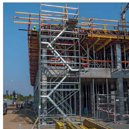
Výstupová schodištvá věž ze systému lešení PERI UP.
