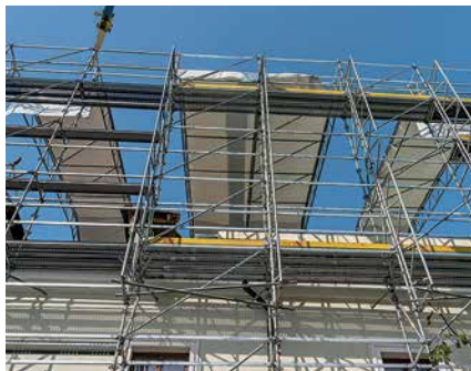
Zajištění tuhosti a stability nosné konstrukce lešení za římsou pomocí příhradových nosníků ULA.
