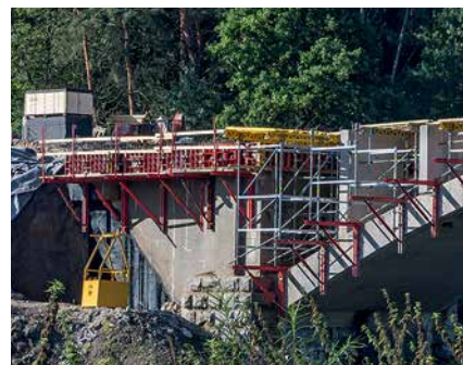
Rozšíření opěry včetně říms s pomocí konzol SRU a lehkého stěnového bednění DOMINO.
