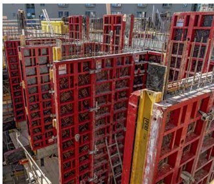
Stěnové bednění MAXIMO MX 18 s výškou panelů 360 cm.
