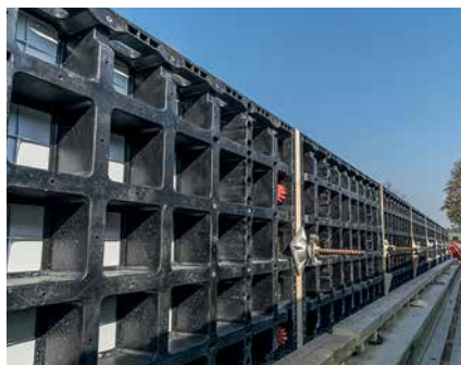
Lehké bednění DUO nasazené na římsu mostu.
