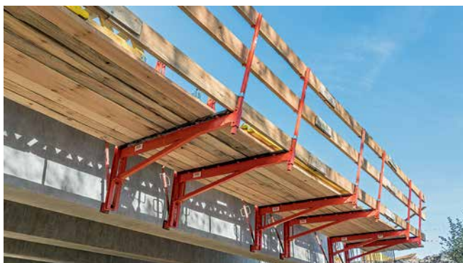
Pracovní lávka VGK nasazená na prefabrikovaných nosnících.
