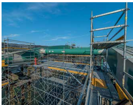
Pracovní podlaha pod vodorovným ztužidlem.
