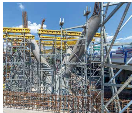
Podpěrná konstrukce z věží ST 100 pro bezproblémový přístup k sloupům.
