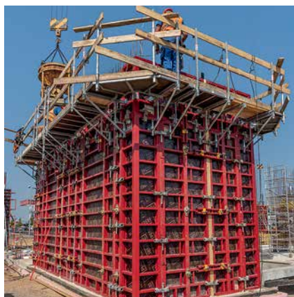
Stěnové bednění MAXIMO s konzolami MXK na výtahové šachtě.
