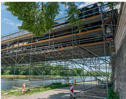
Překlenutí komunikace pomocí příhradového vazníku.
