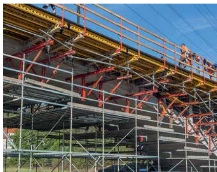
Zavěšená konstrukce z lešení PERI UP nad vodní hladinou.
