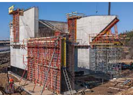
Nasazení systému TRIO a věží ST 100 na opěře.
