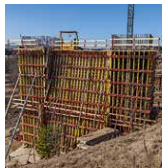
Forma pilíře ze systému VARIO vyrobená v montážní hale PERI.
