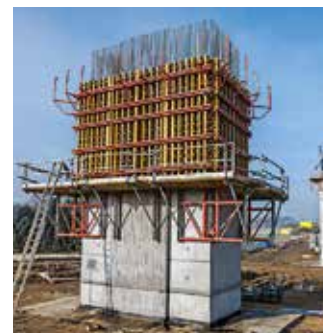
Nasazené bednění VARIO na lávkách FB u standardních pilířů.
