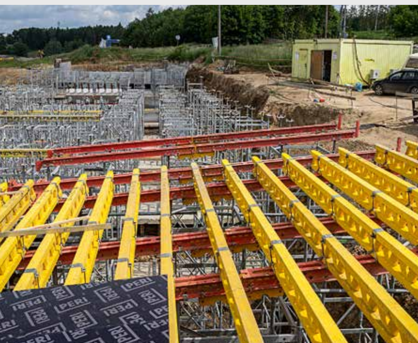
Schéma podepření prefabrikátu vzpěry systémem VARIOKIT.
