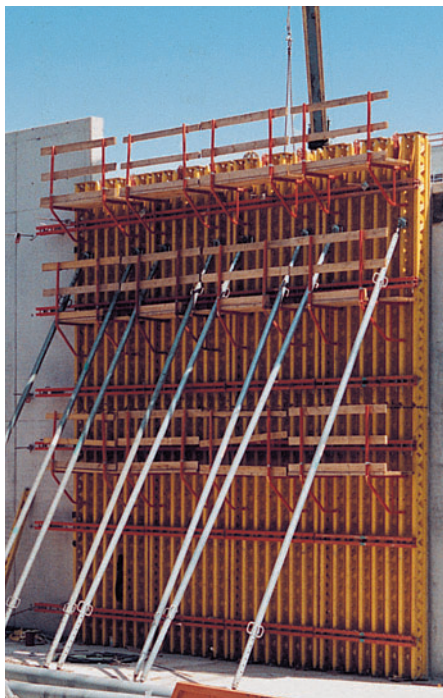
Nastavené panely VARIO GT 24 na stavbě administrativní budovy.
