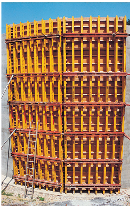
7,50 m vysoké kruhové bednění získané vložení ramenátů mezi nosníky a překližku.
