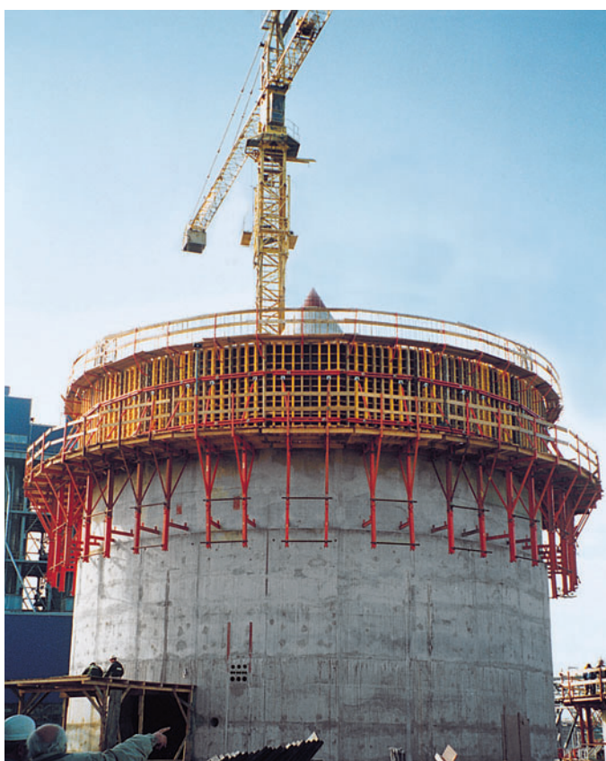
VARIO GT 24 na stavbě kruhového síla. Kruhový tvar vytvořily dřevěné klíny vložené mezi nosníky a závory.
