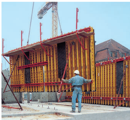
VARIO GT 24 na stavbě obytného domu.
