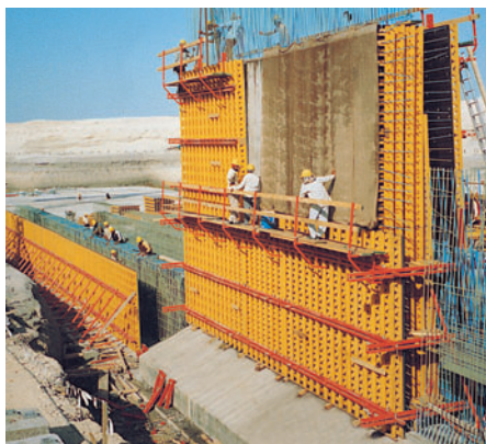
VARIO GT 24 na stavbě čističky u stěn kónického tvaru.
