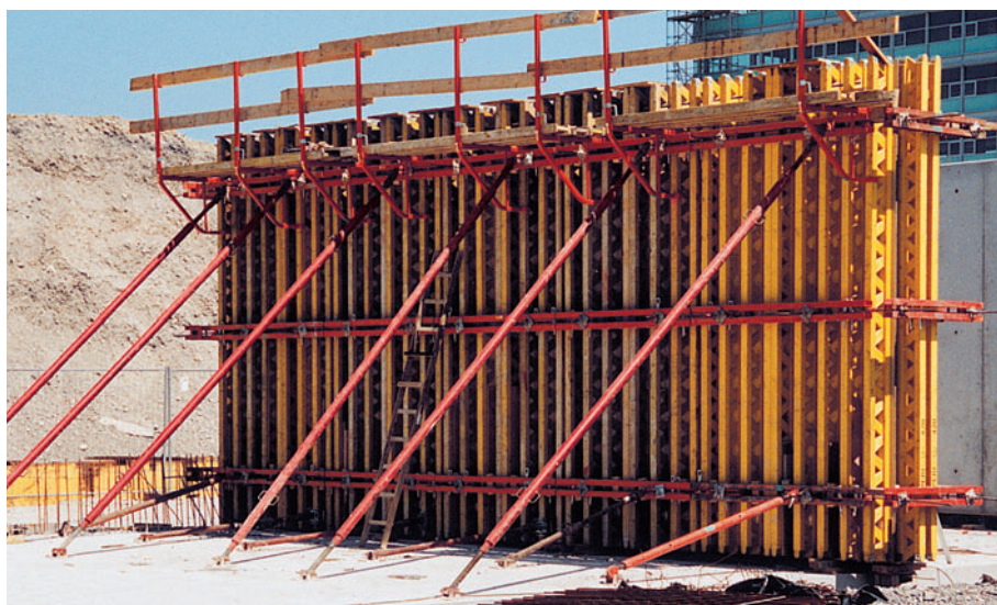
Začilkované bednění stěny vysoké 4,20 m.
