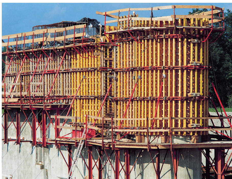
Přední strana pilířového valu VARIO v kombinaci s kruhovým bedněním GRV na překládaném lešení KGF 240.
