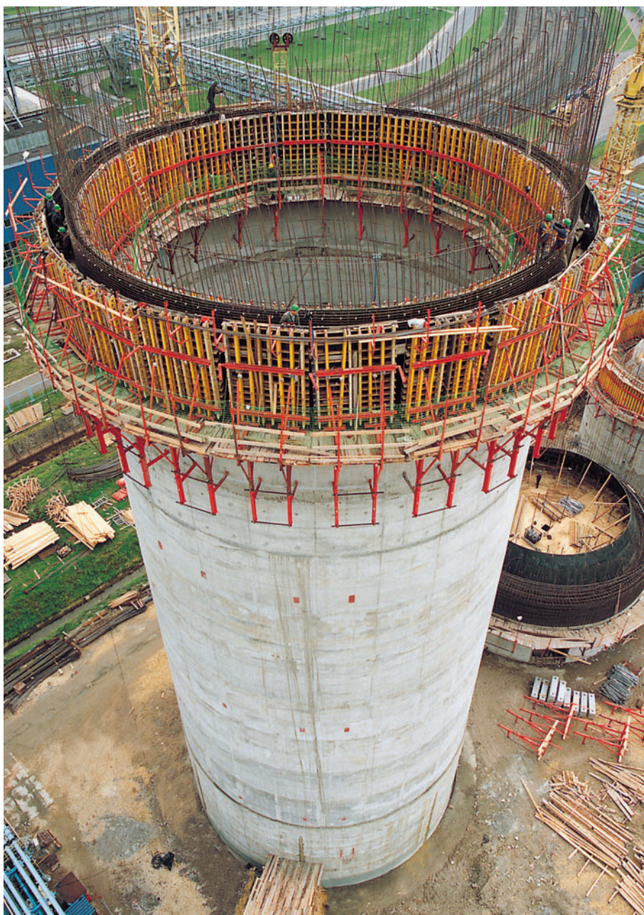
Silo, h = 72 m, \phi = 20 m elektrárny v Oppelnu, Polsko. Kruhové nosíkové bednění VARIO na překládaném lešení KGF.
