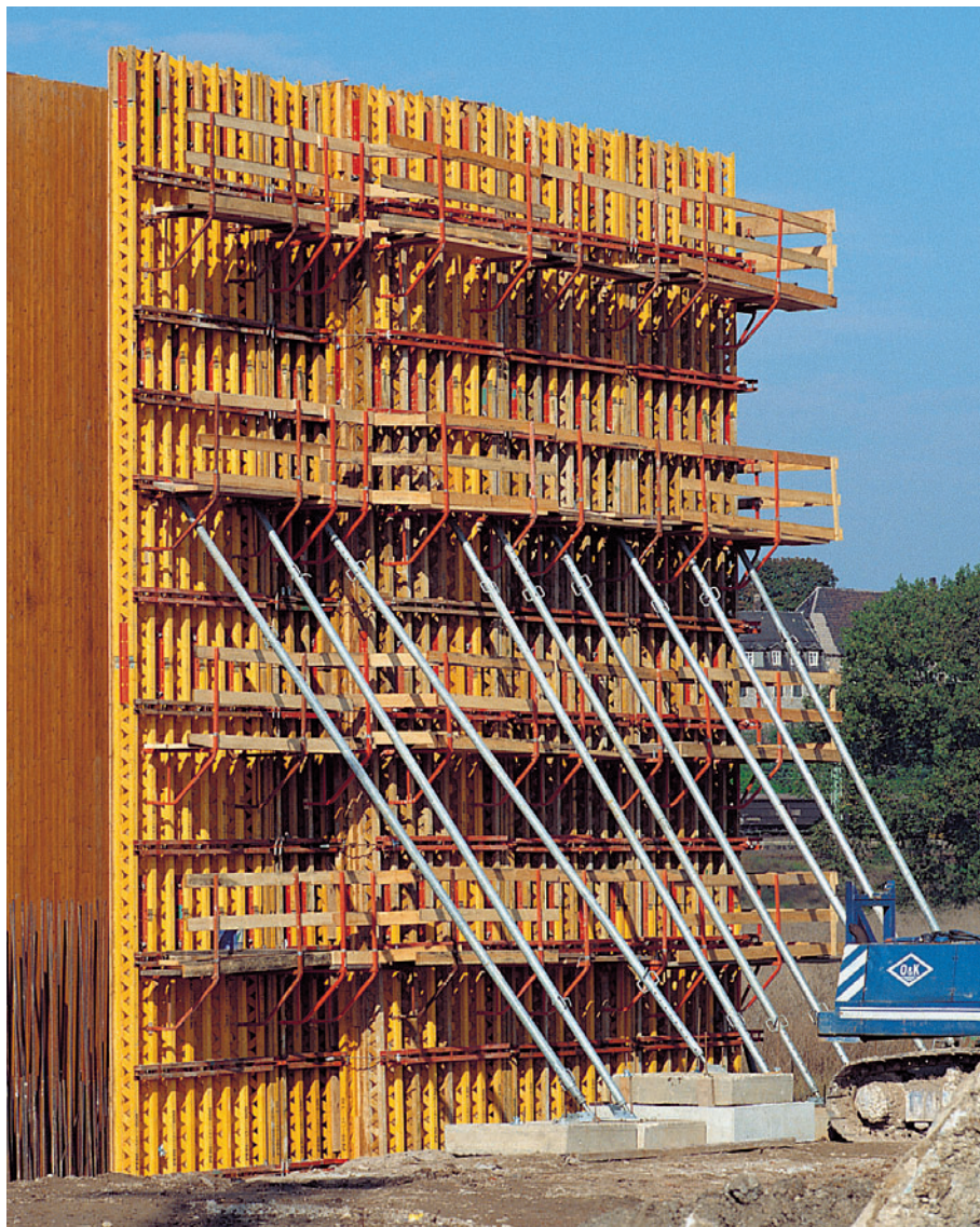
Stěna vysoká 10,70 m s dvakrát nastavovaným bedněním VARIO GT 24.
