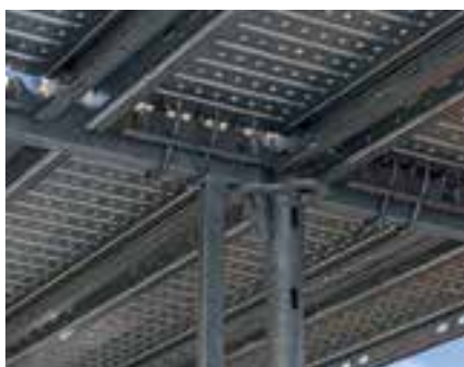
Pojistka proti nazdvihnutí je integrovaná v podlaze: pojistka zapadne pod horizontálu a podlahu tím zajistí.
