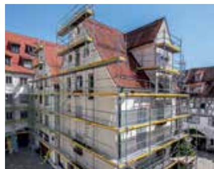
Montáž základního lešení následuje téměř bez spojovacích dílů. Systém rychlého ukotvení Easy zkracuje dobu montáže.
