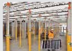
Stropní bednění
