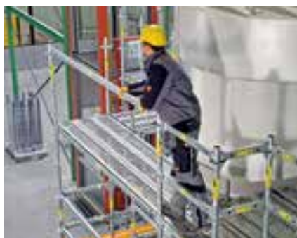
Gravity Lock umožňuje snadnou montáž ze zabezpečeného místa, klín zapadne vlastní vahou do otvoru v rozetě.
