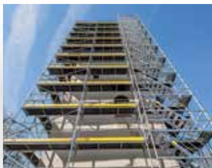
Na rozetu rámu Easy je možné připojit přímo např. také schodiště - bez dalších rámu nebo konstrukčních dílů.
