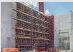
Pracovní lešení na staveništích
