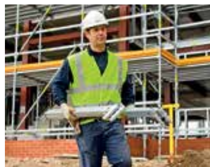
Malá šířka průřezu horizontály umožňuje jednomu pracovníkovi přenášet až 4 horizontály najednou.
