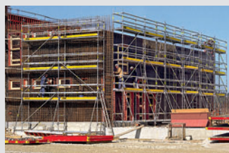
Pracovní lešení na staveništích
