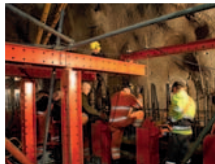
Systémové díly bednicího vozu a pojízdného zavěšeného bednění umožňují flexibilní nasazení.
