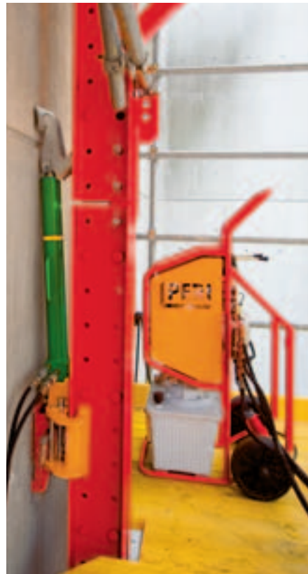
Kolejnice RCS s hydraulickým zařízením pro šplhání.
