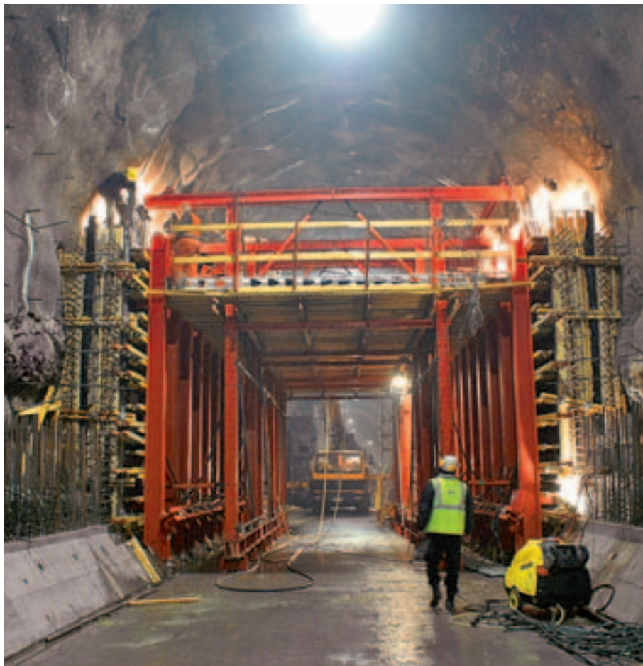
V prvním záběru je betonováno dno a náběhy.
