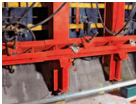
Zkušenosti z kotvení opěrných rámu mohou být využity i ve 2. záběru.
