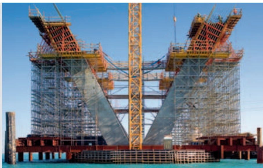
Variabilní řady nosných příhradových vazeb pro přenos zatížení způsobeného čerstvým betonem a jako dočasné podepření stavební konstrukce.
