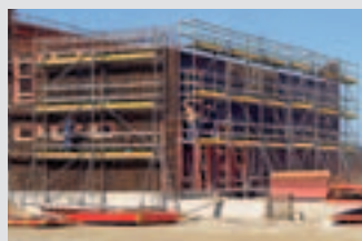
Pracovní lešení na staveništích
