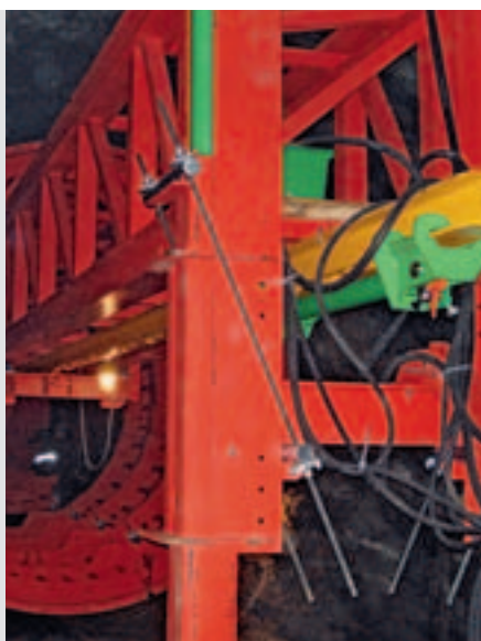
a poklesové jednotky a hydraulické válce pro obsluhu stěnových a stropních panelů bednění
