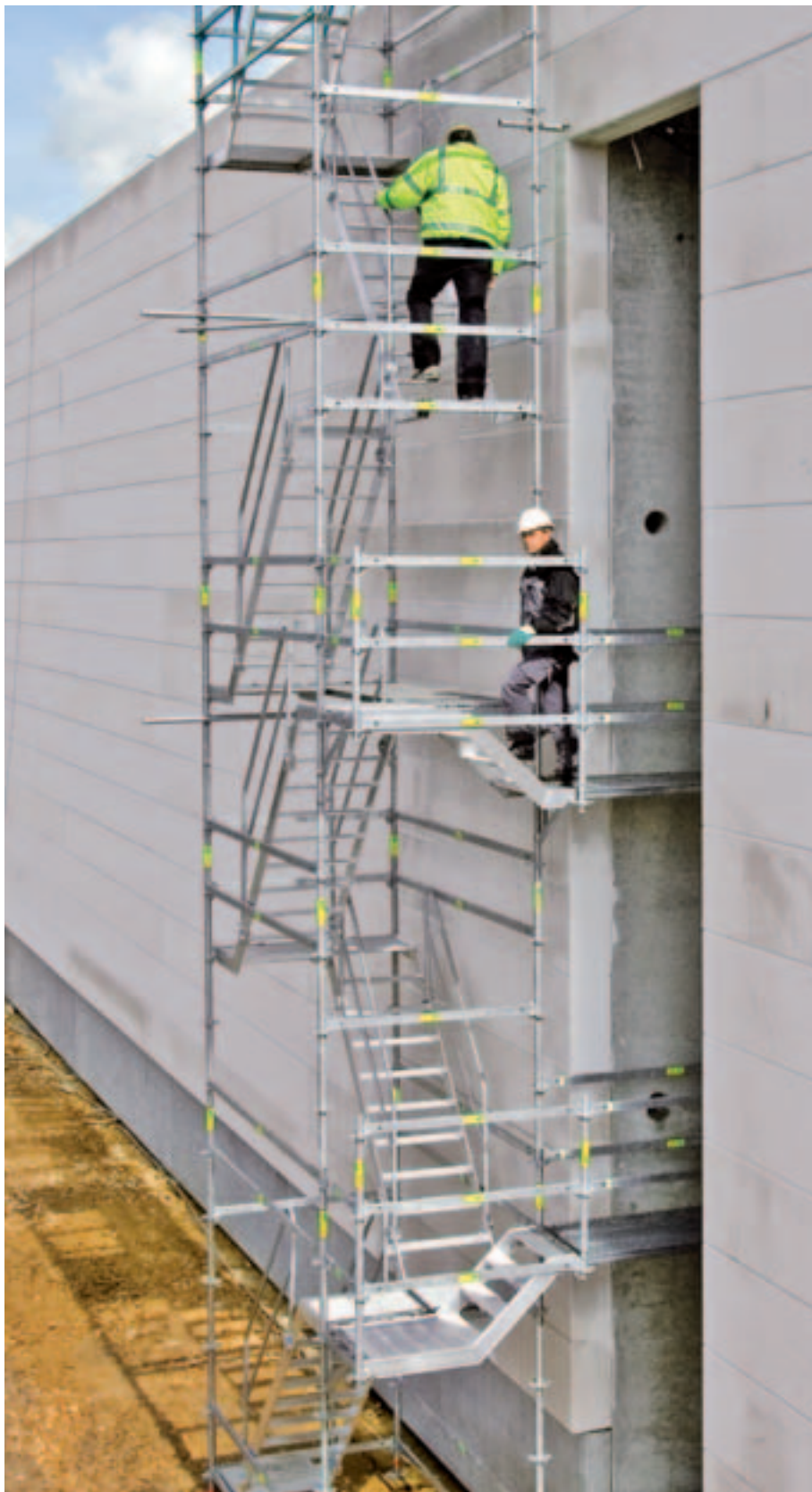
Přizpůsobení výšce vstupu do budovy se montuje nezávisle na výšce podlaží.
