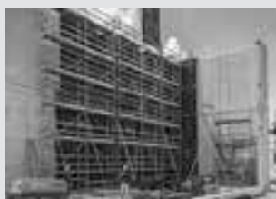
Pracovní lešení na staveništích
