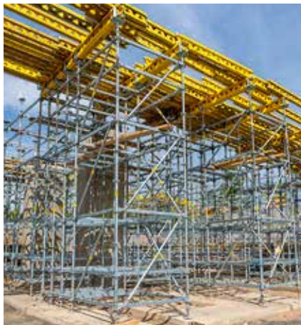
Podsružení části mostovky z variabilního systému lešení PERI UP.
