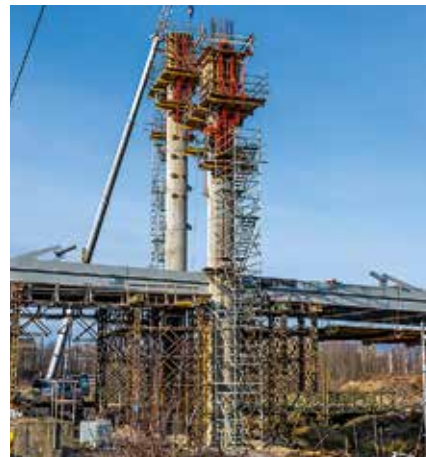
Šplhavé bednění RCS a přístupové schodišťové věže z lešení PERI UP pro bednění pylonu.
