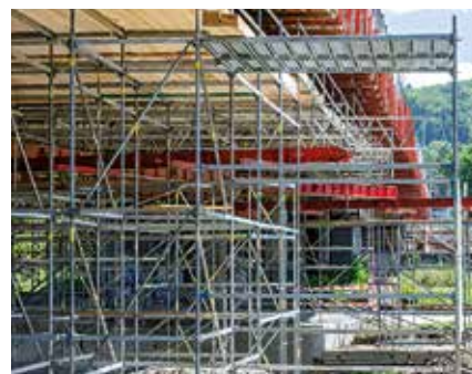
Prostorové lešení PERI UP umístěné pod sanovaným mostem.
