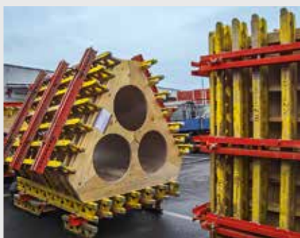
Forma pro bednění stromosloupu ze systémového bednění VARIO a dřevěných ramenátů.
