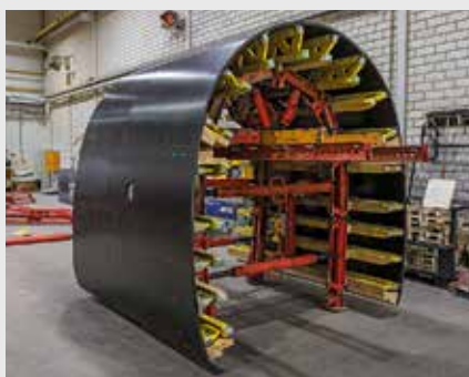
Bednění klenbového krčku sestavené ze systému GRV a opláštěné tenkovrstvou překližkou.
