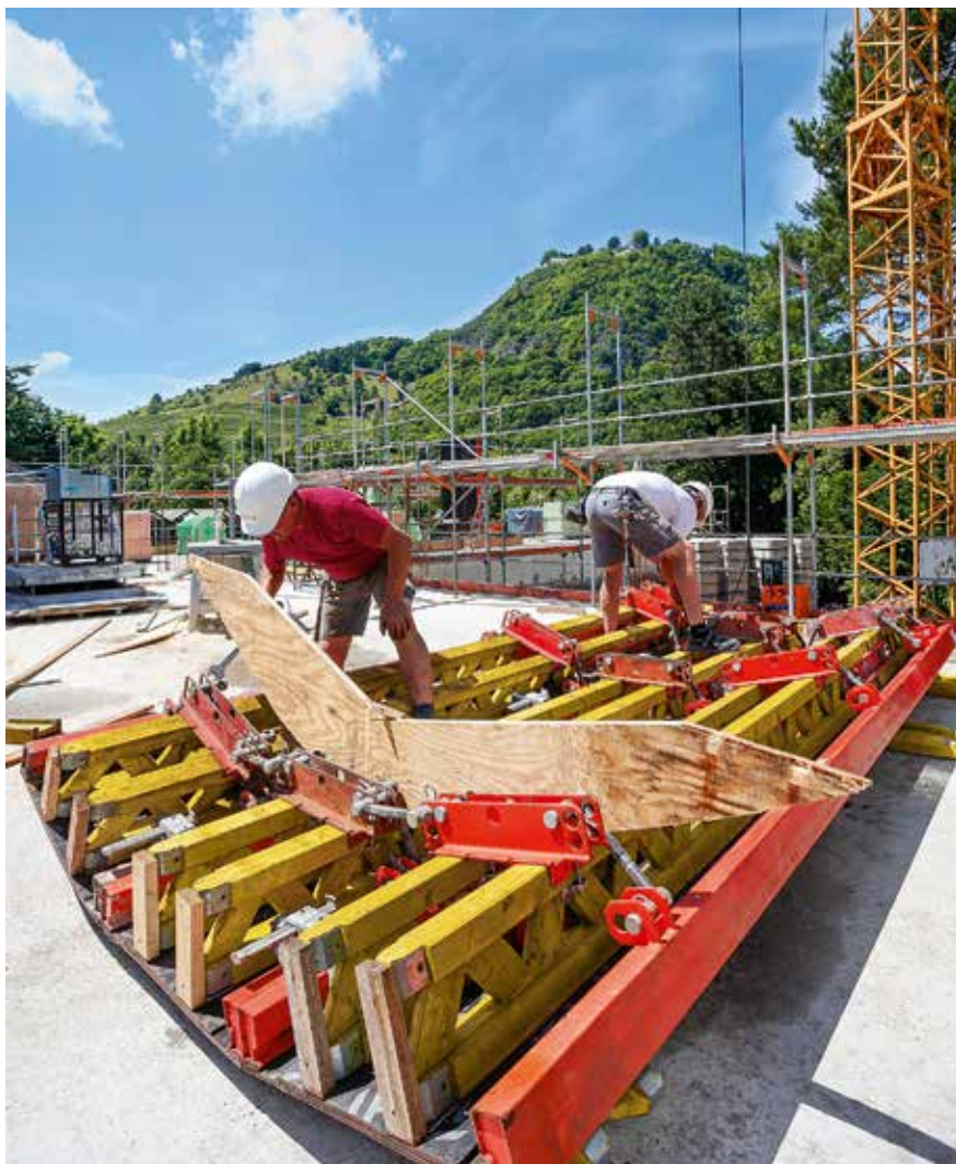
Dané zakřivení se kontroluje umístěním šablony poloměru na nosíky bednění.
