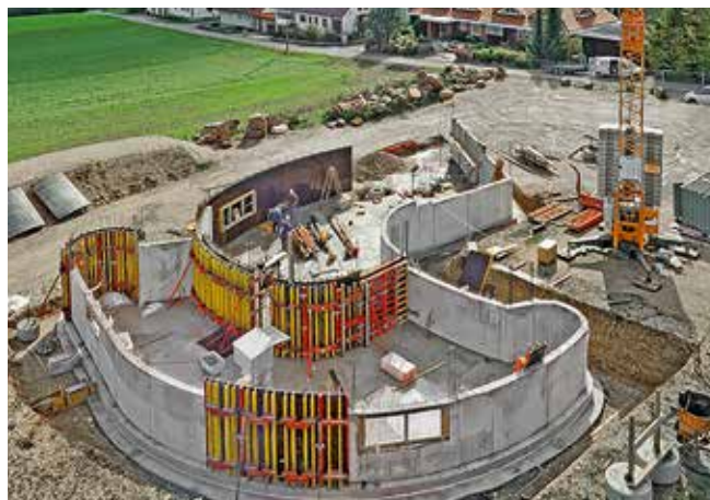
Mimořádná výzva v obytné výstavbě: železobetonové stěny s neustále se měnícími poloměry a vysunutými obytnými plochami.
