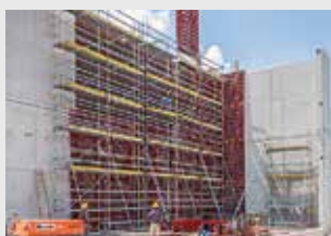
Pracovní lešení na staveništích
