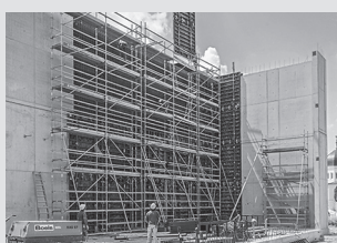
Pracovní lešení na staveništích
