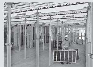
Stropní bednění
