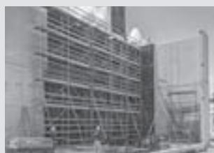
Pracovní lešení na staveništích
