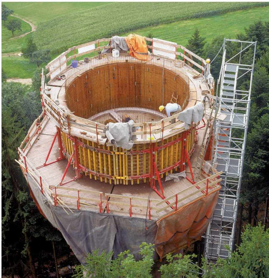
Kruhové bednění GRV postavené na lešení pro překládané bednění PERI KGF 240.
