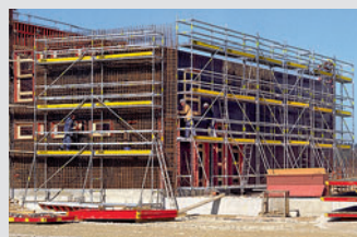
Pracovní lešení na staveništích
