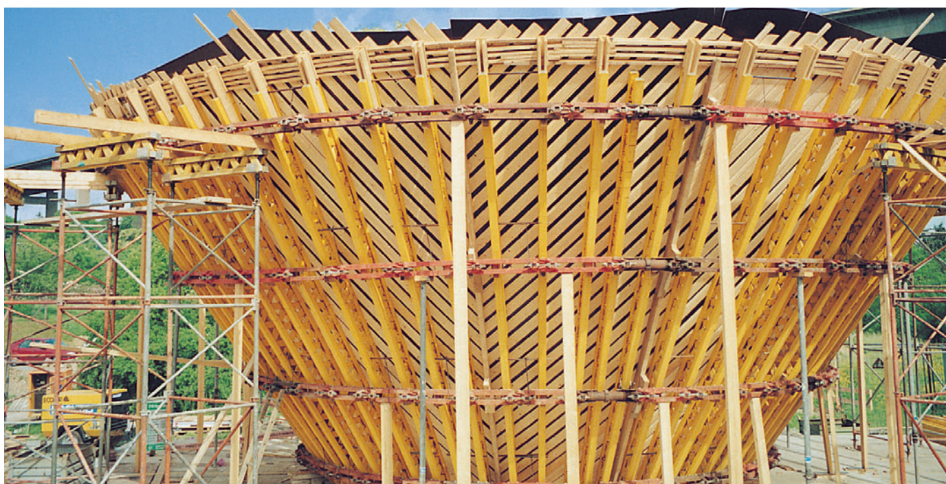
Bednění ve tvaru trychtýře pro výrobu čistící nádrže dešťové vody.
