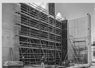
Pracovní lešení na staveništích
