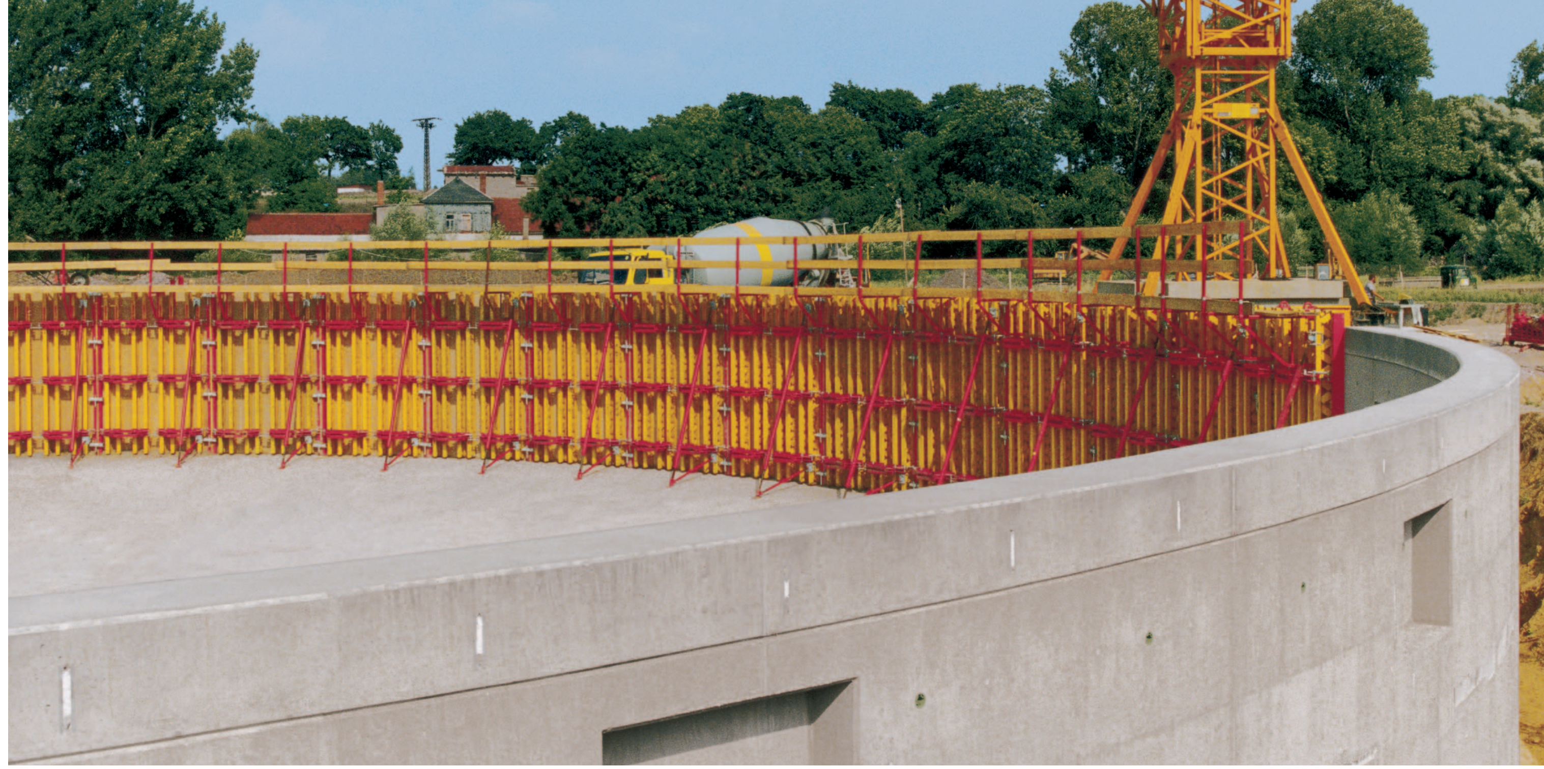
S patentovaným, samočinným napínacím vřetenem se šestižebrem je možné nastavit jakékoliv kruhové bednění od poloměru 1,00 m.
