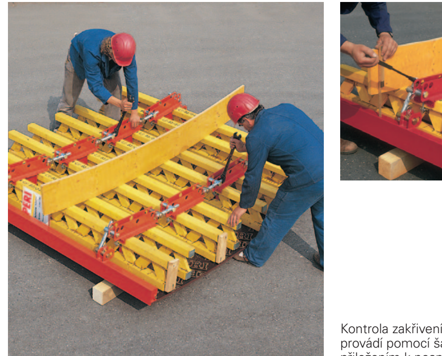
Kontrola zakřivení se provádí pomocí šablony přiložené k nosníku.
