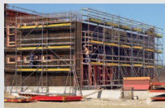
Pracovní lešení na staveništích
