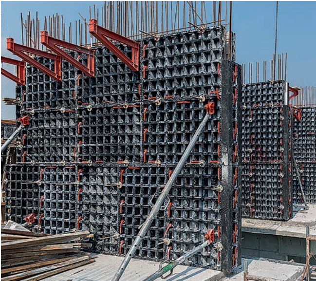
Úspěšné první použití lehkého univerzálního bednění pro výrobu velkých stěn.
