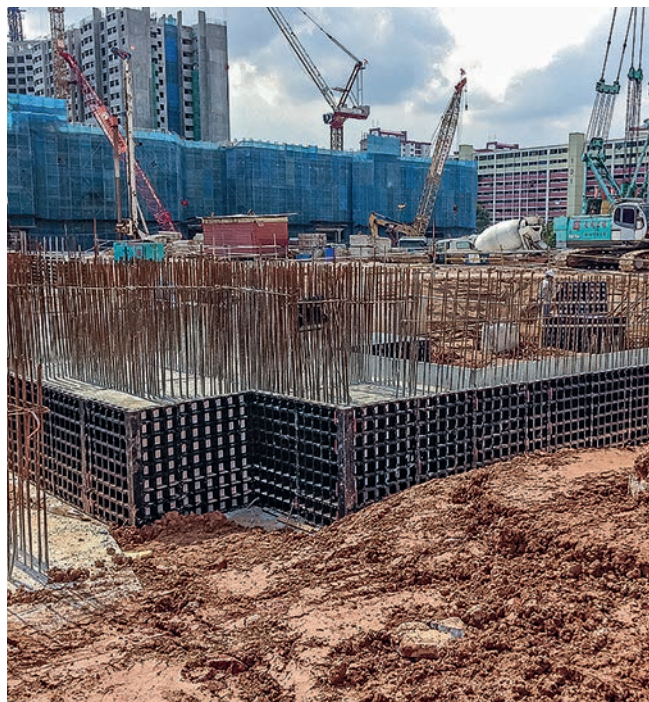
Panely DUO se ideálně hodily pro tvarování betonových dílců malých rozměrů s nízkými nároky na povrch.
