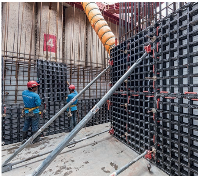
Malá hmotnost panelů bednění s malými rozměry – tyto výhody systému DUO se zde opět vyplatily.
