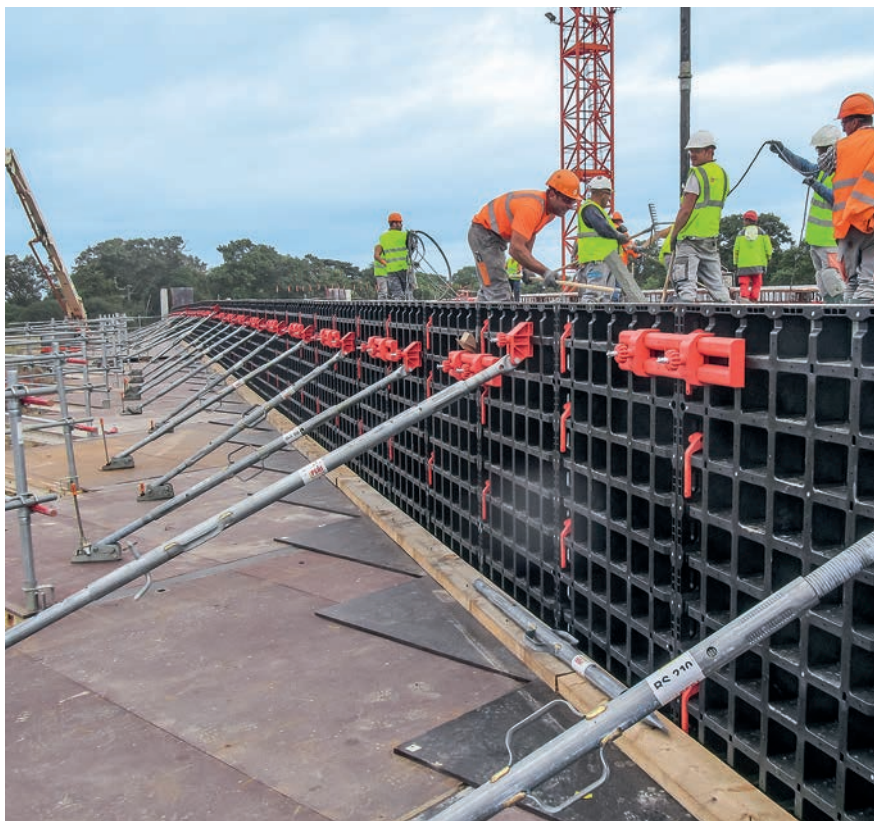
DUO je se svými malými panely a snadnou manipulací předurčeno pro bednění základů.
