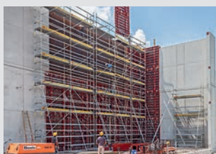
Pracovní lešení na staveništích
