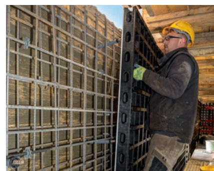
Lehké bednicí prvky DUO byly ideální pro stavbu ve stávajících konstrukcích.
