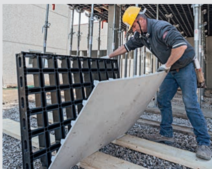
2. Odstranění poškozené bednicí desky
